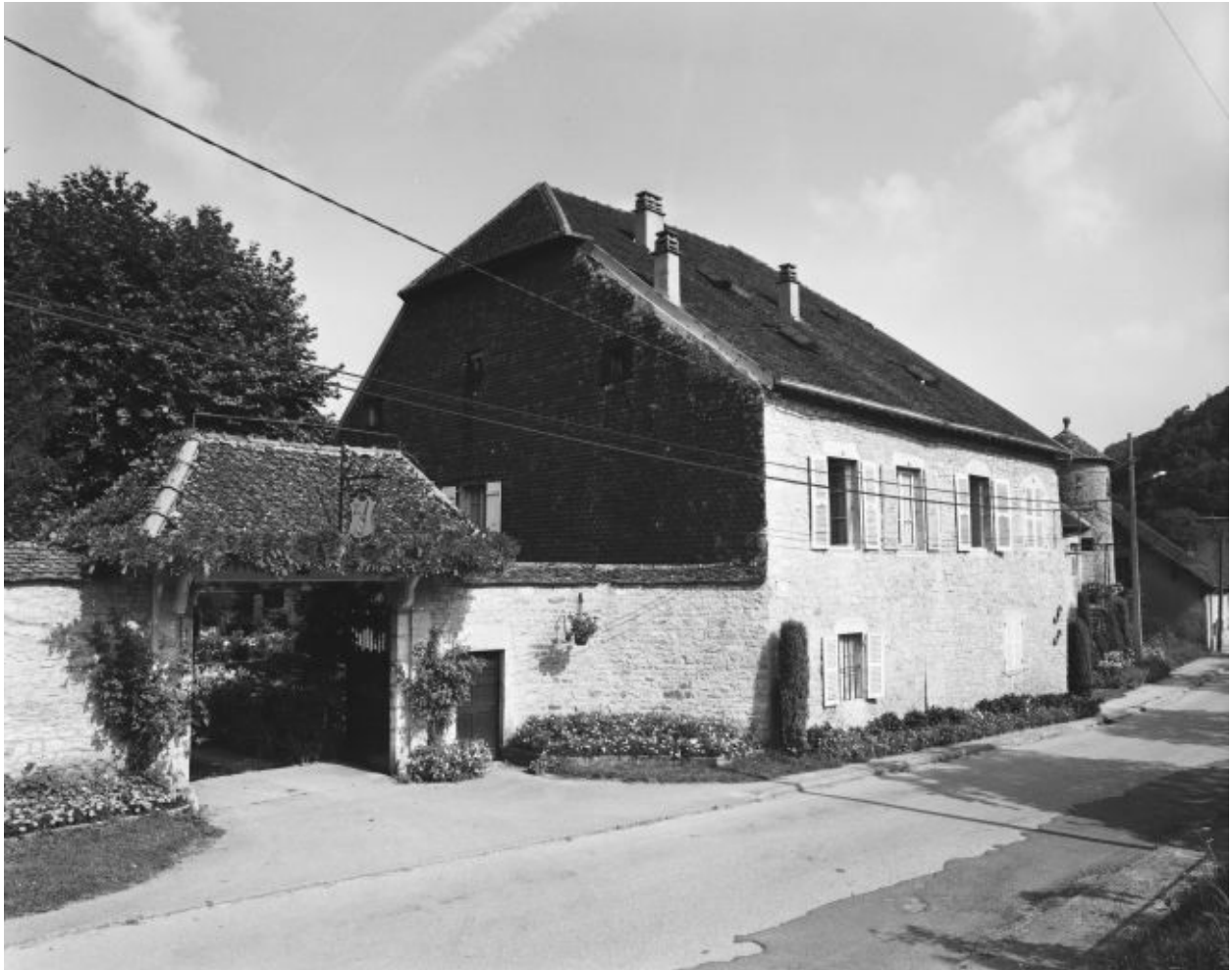
Bâtiment d'habitation vu depuis la rue.
