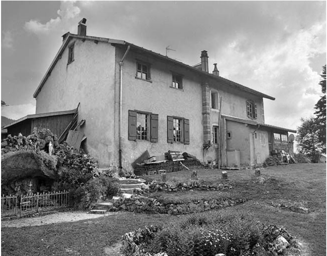
Façade postérieure et face droite.
