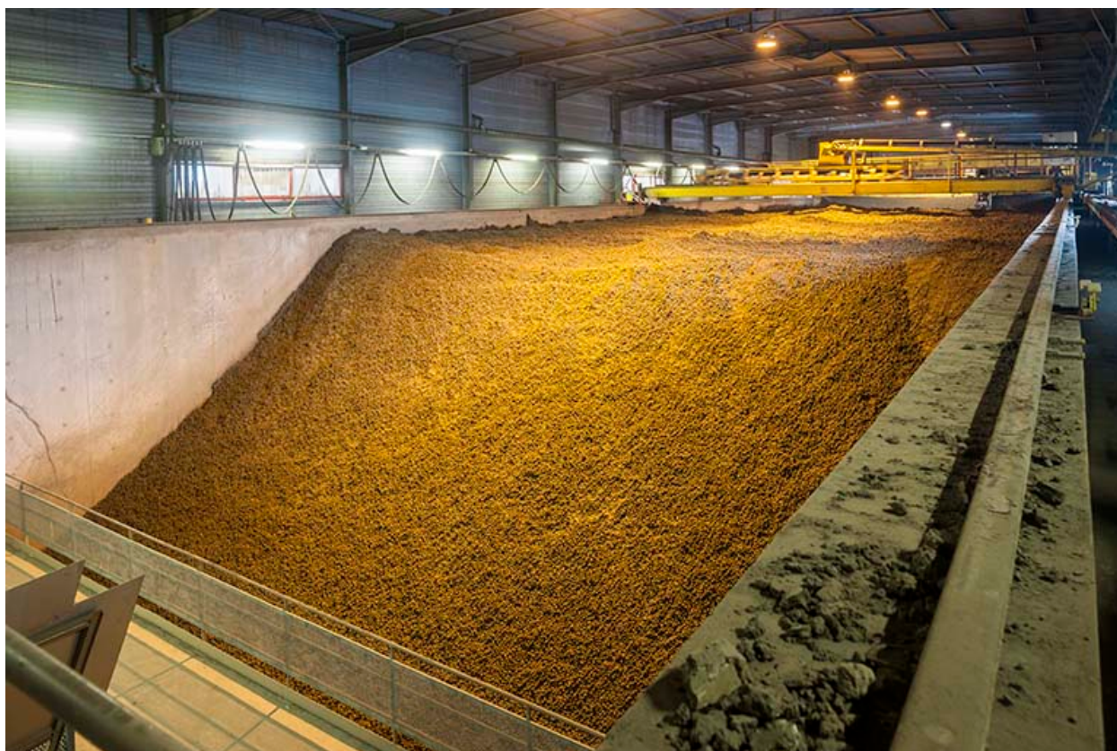
Fosse à terre (homogénéisation, maturation). Vue d'ensemble.
