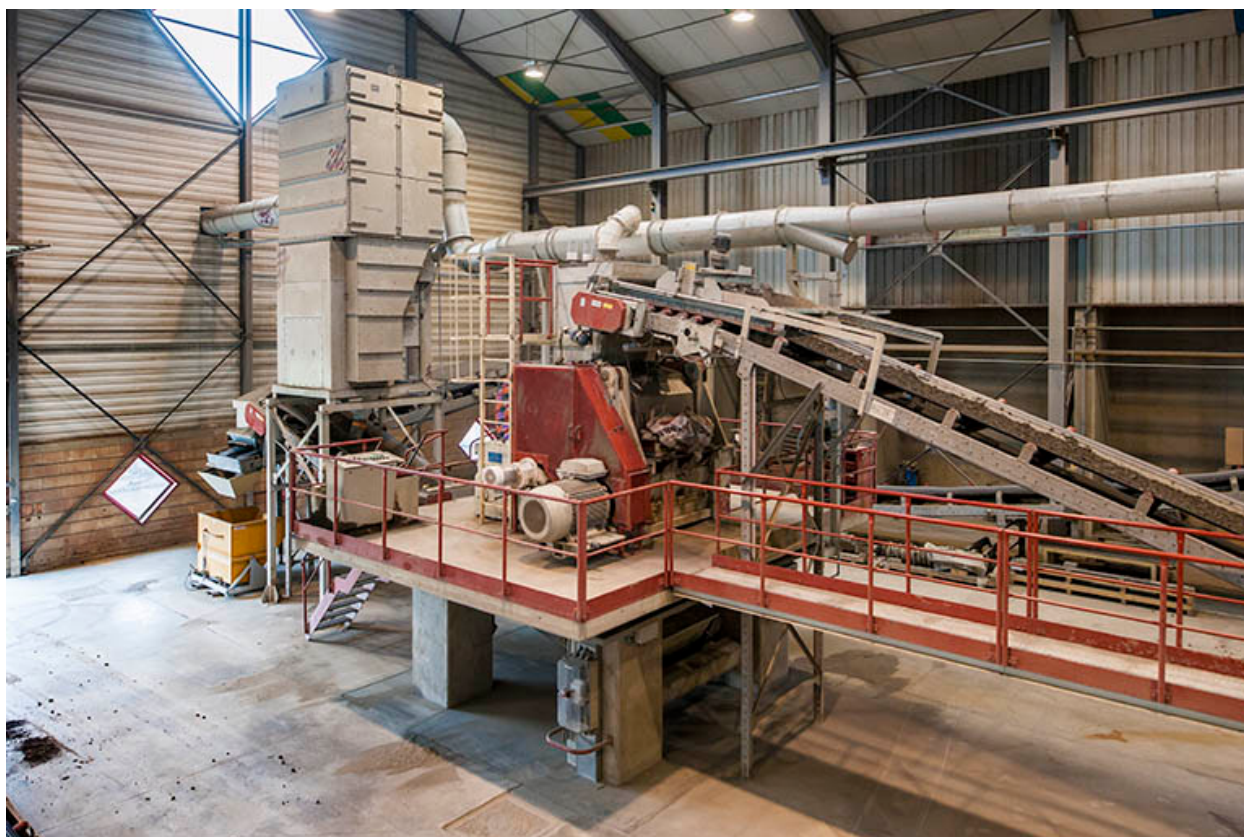
Unité de préparation des terres. Laminoir-finisher.
