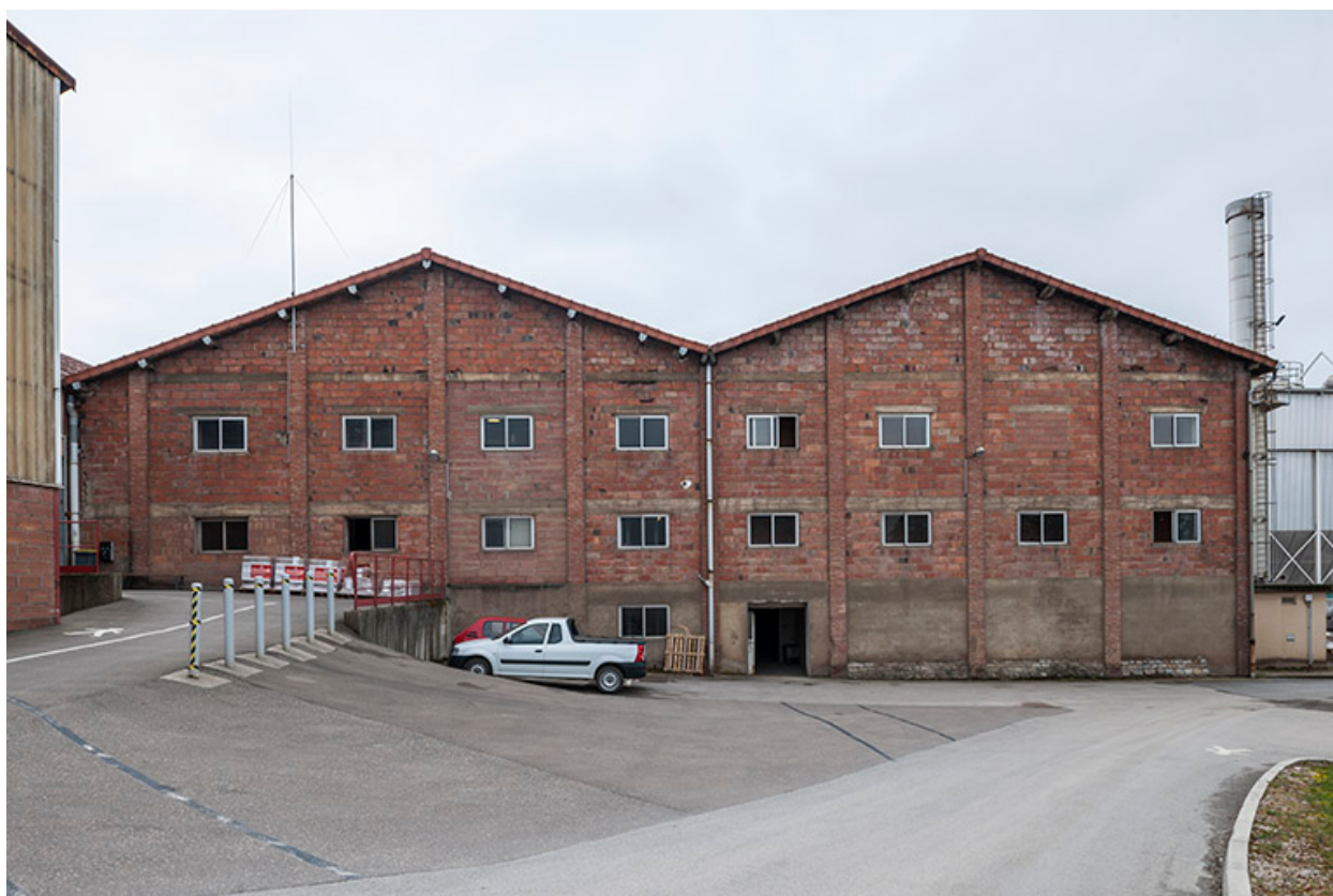
Murs-pignons de l'atelier de fabrication (actuellement UL 3).
