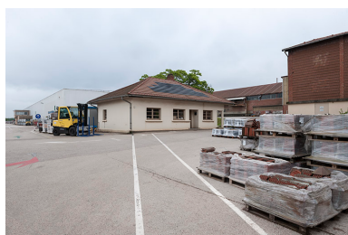
Laboratoire. Phot. Jérôme Mongreville IVR43_20152501311NUC4A
