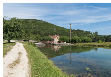
Vue d'ensemble. Phot. Pierre-Marie Barbe-Richaud IVR26_20128900325NUC2AQ
