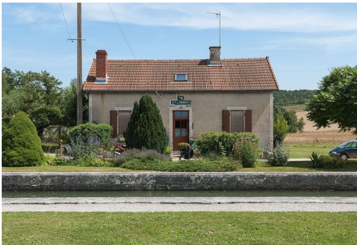
Maison éclusière, vue de face.
