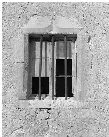
Une fenêtre au linteau en accolade. Phot. Jérôme Mongreville IVR43_19963901553X
