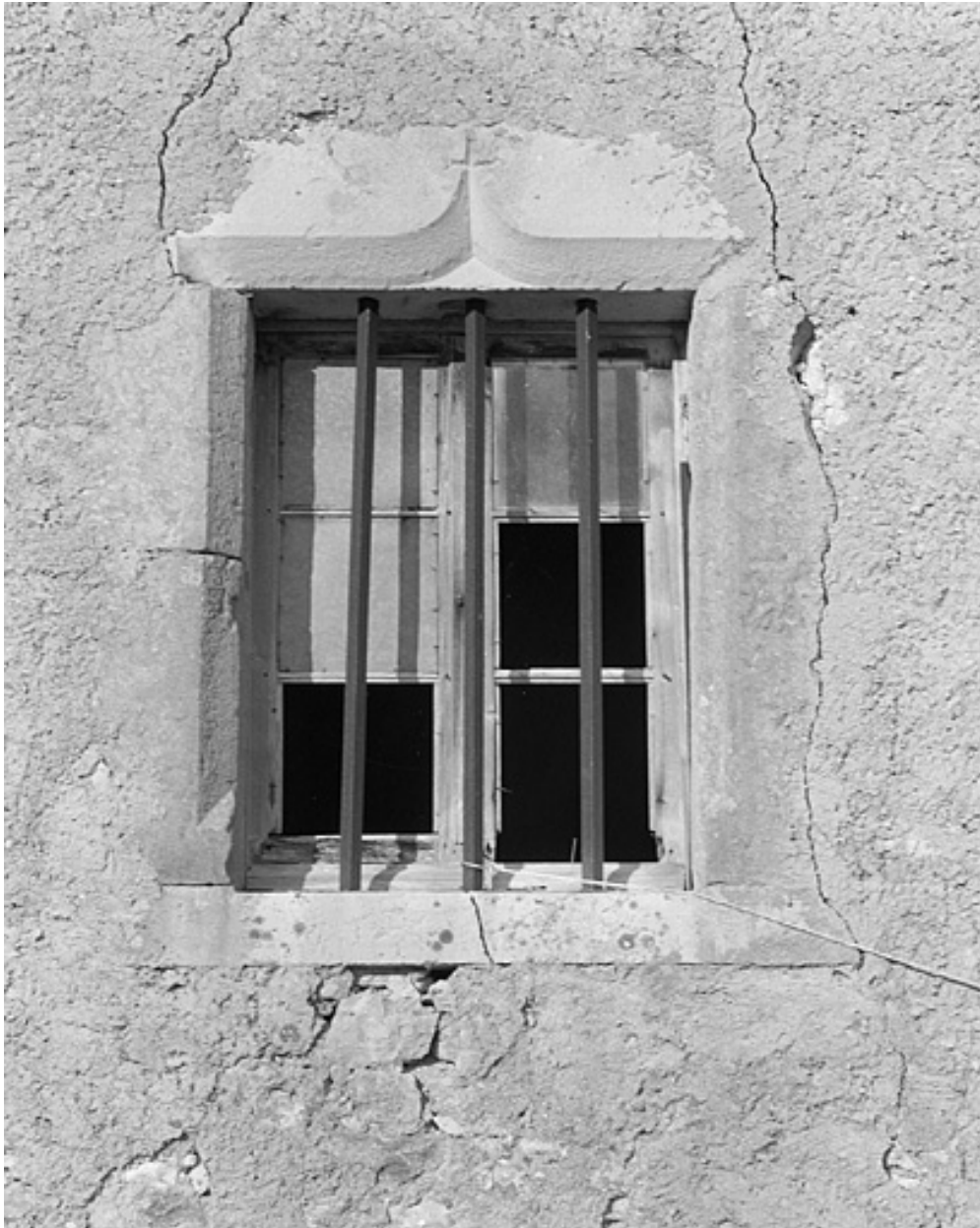
Une fenêtre au linteau en accolade.
