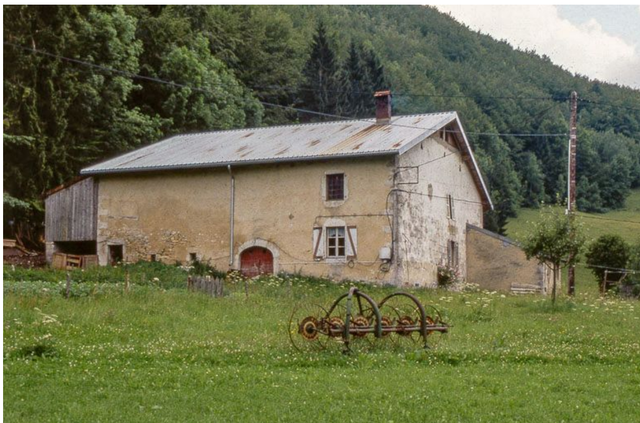
Vue éloignée de la façade postérieure.
