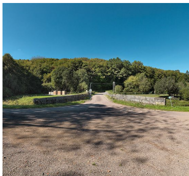
Vue d'ensemble du pont, avec les parapets.
