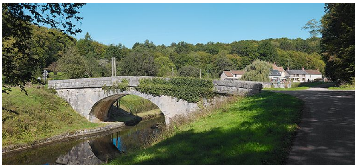
Vue d'ensemble du pont.
