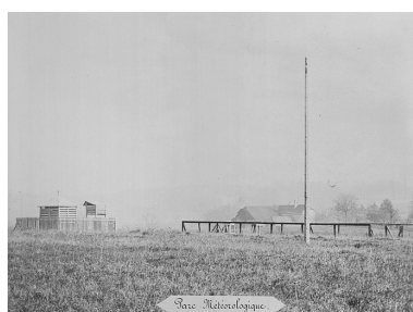
Parc météorologique, fin 19e siècle. Phot. Jérôme Mongreville IVR43_20032500573V
