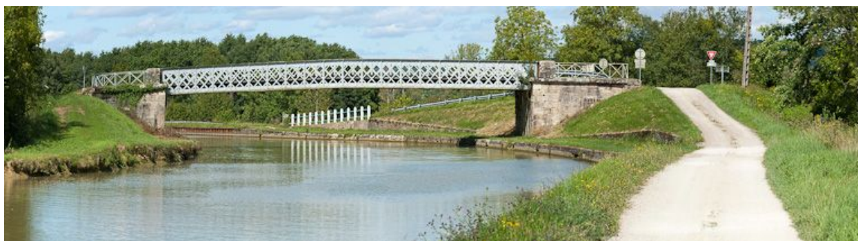
Vue du pont.
