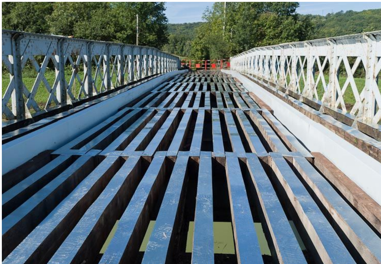
Vue du tablier pendant les travaux.
