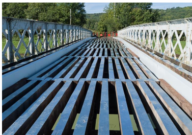
Vue du tablier pendant les travaux. Phot. Pierre-Marie Barbe-Richaud IVR26_20112104076NUC4AQ
