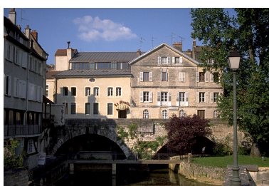
Façade antérieure. Phot. Laurent Poupard
