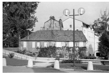
Atelier de réparation et bureau, depuis l'est. Phot. Laurent Poupard IVR43_19893900138Z
