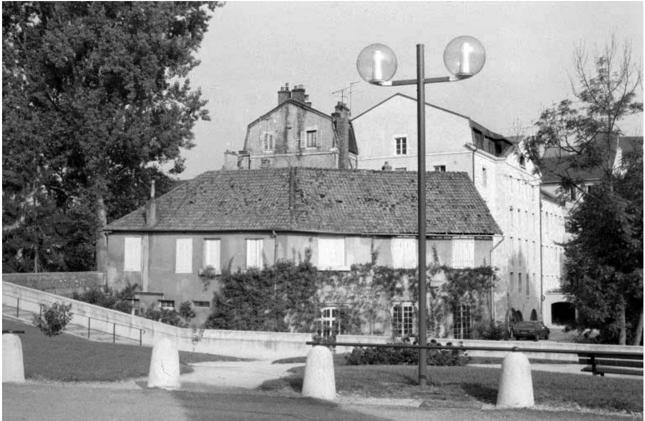
Atelier de réparation et bureau, depuis l'est.
