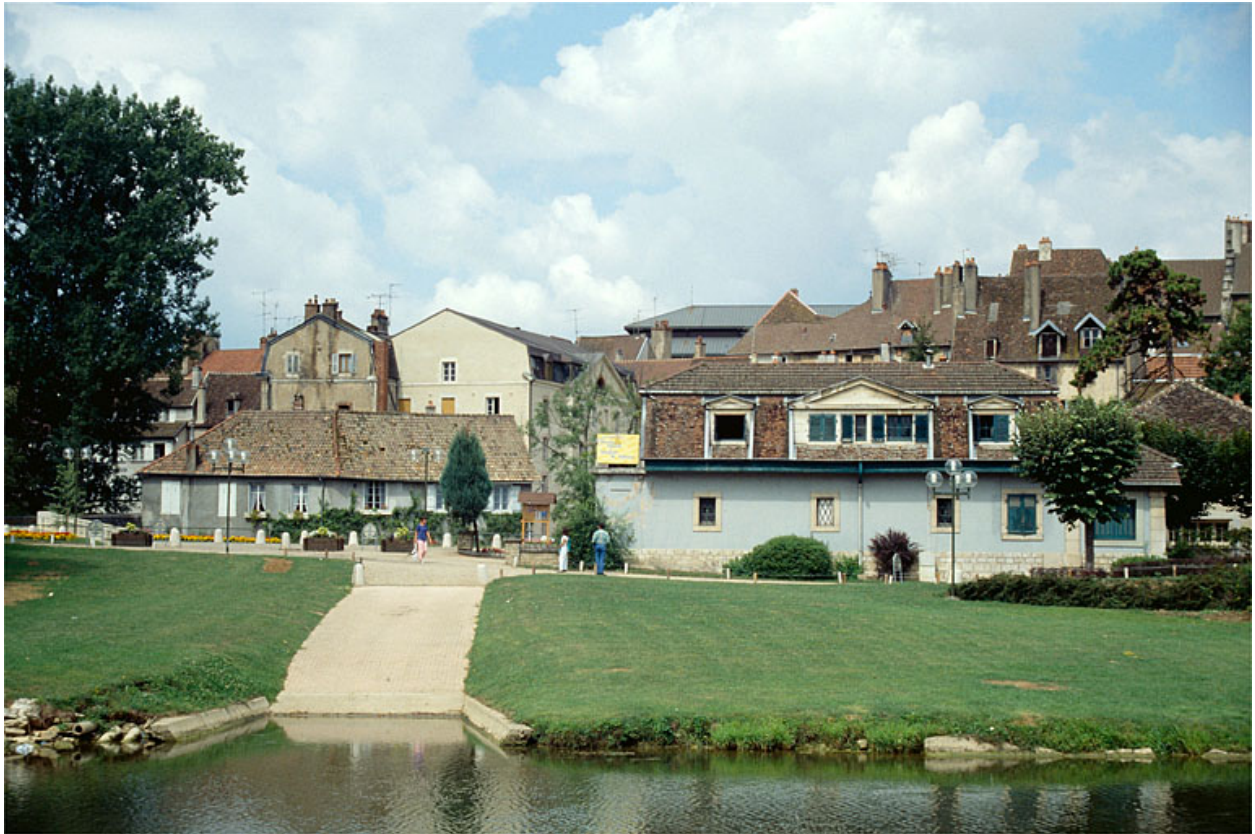
Bureau et logement d'ouvriers (H), depuis l'est.
