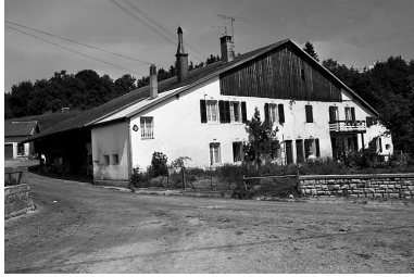
Vue de trois quarts. Phot. Dominique Dominguez IVR43_19792500952X
