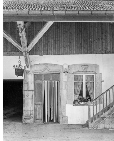
Détail : porte d'entrée. Phot. Dominique Dominguez IVR43_19792500954X
