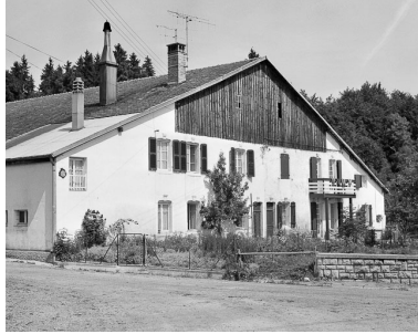
Pignon d'habitation. Phot. Dominique Dominguez IVR43_19792500953X
