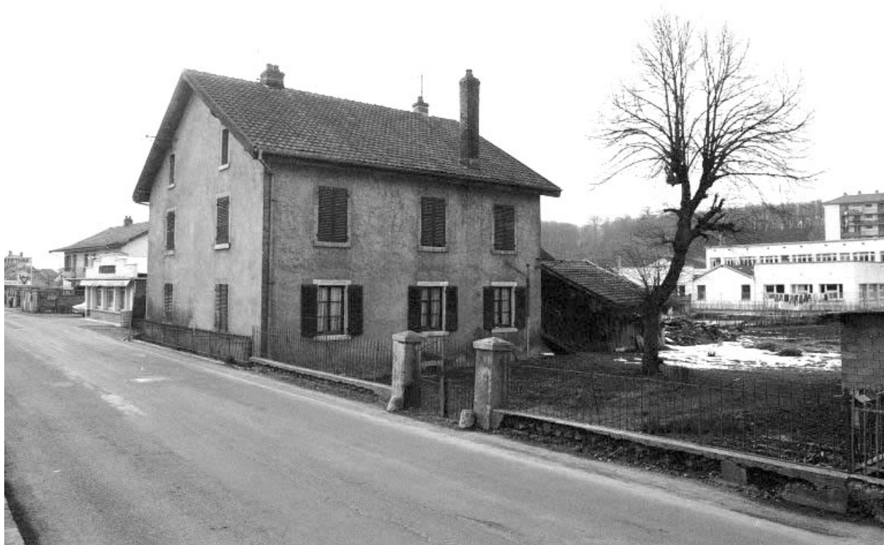
Façades postérieure et latérale droite.
