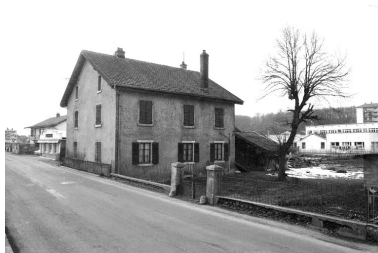
Façades postérieure et latérale droite.
