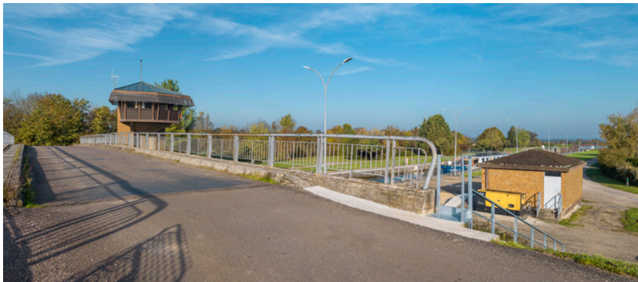
Vue d'ensemble depuis le pont sur écluse.
