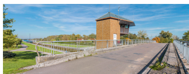
Vue d'ensemble du site d'écluse et du poste de commande. Phot. Thierry Kuntz IVR26_20172100533NUC4A
