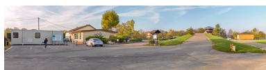
Le centre d'exploitation VNF, sur la rive gauche du site d'écluse. Phot. Thierry Kuntz IVR26_20172100512NUC4A
