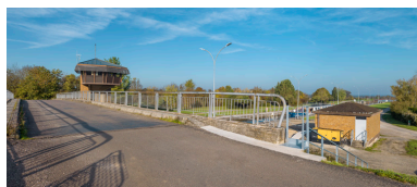
Vue d'ensemble depuis le pont sur écluse. Phot. Thierry Kuntz IVR26_20172100532NUC4A
