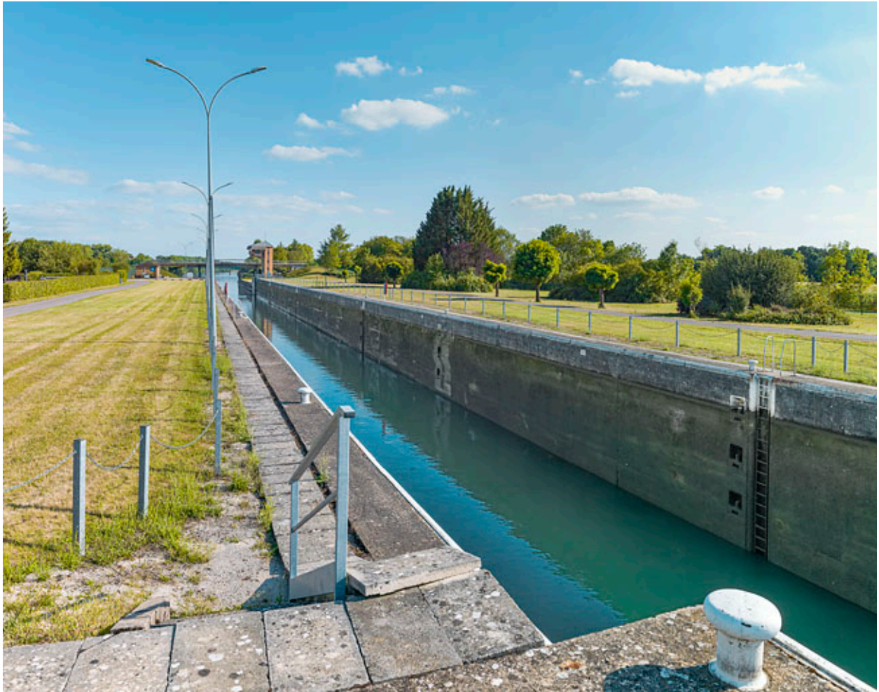
Vue d'ensemble du sas.
