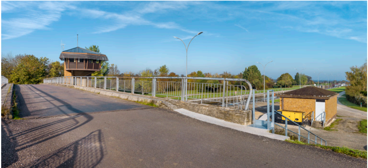
Vue d'ensemble depuis le pont sur écluse.
