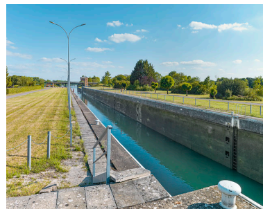
Vue d'ensemble du sas. Phot. Thierry Kuntz IVR26_20192100140NUC4A
