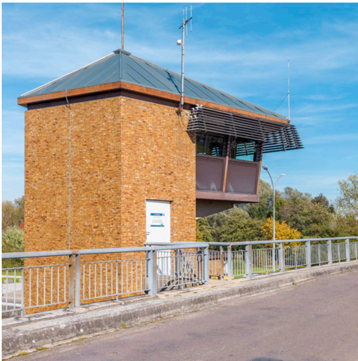
Vue rapprochée de la tour de contrôle.
