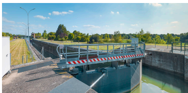
Vue d'ensemble des portes amont de l'écluse. Phot. Thierry Kuntz IVR26_20192100139NUC4A
