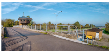
Vue d'ensemble depuis le pont sur écluse. Phot. Thierry Kuntz IVR26_20172100531NUC4A
