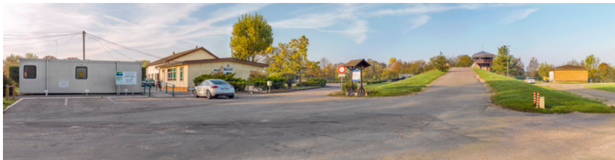
Le centre d'exploitation VNF, sur la rive gauche du site d'écluse.
