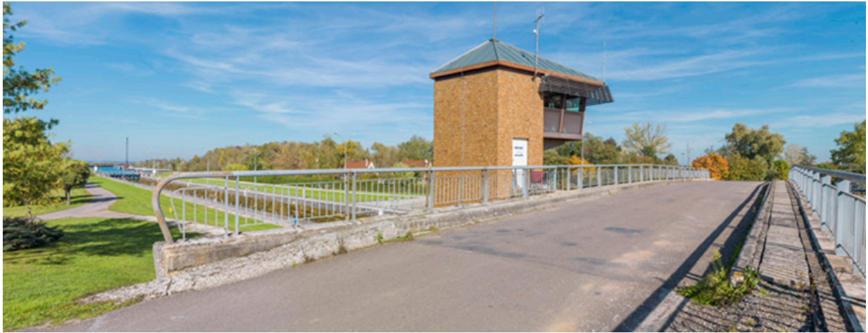
Vue d'ensemble du site d'écluse et du poste de commande.
