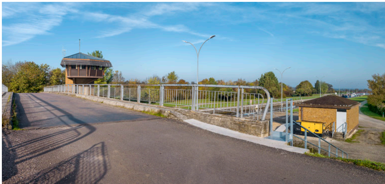
Vue d'ensemble depuis le pont sur écluse.
