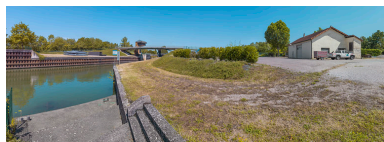
Vue d'aval du site et du centre d'exploitation VNF. Phot. Thierry Kuntz IVR26_20192100141NUC4A
