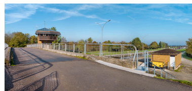
Vue d'ensemble depuis le pont sur écluse. Phot. Thierry Kuntz IVR26_20172100530NUC4A
