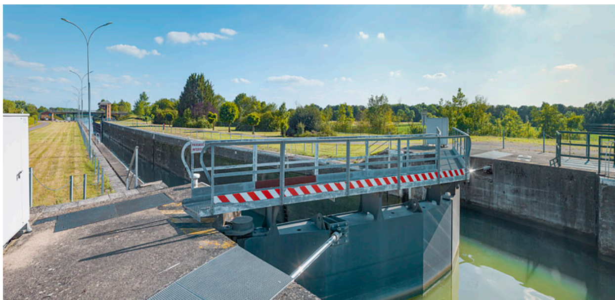
Vue d'ensemble des portes amont de l'écluse.
