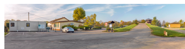
Le centre d'exploitation VNF, sur la rive gauche du site d'écluse. Phot. Thierry Kuntz IVR26_20172100511NUC4A
