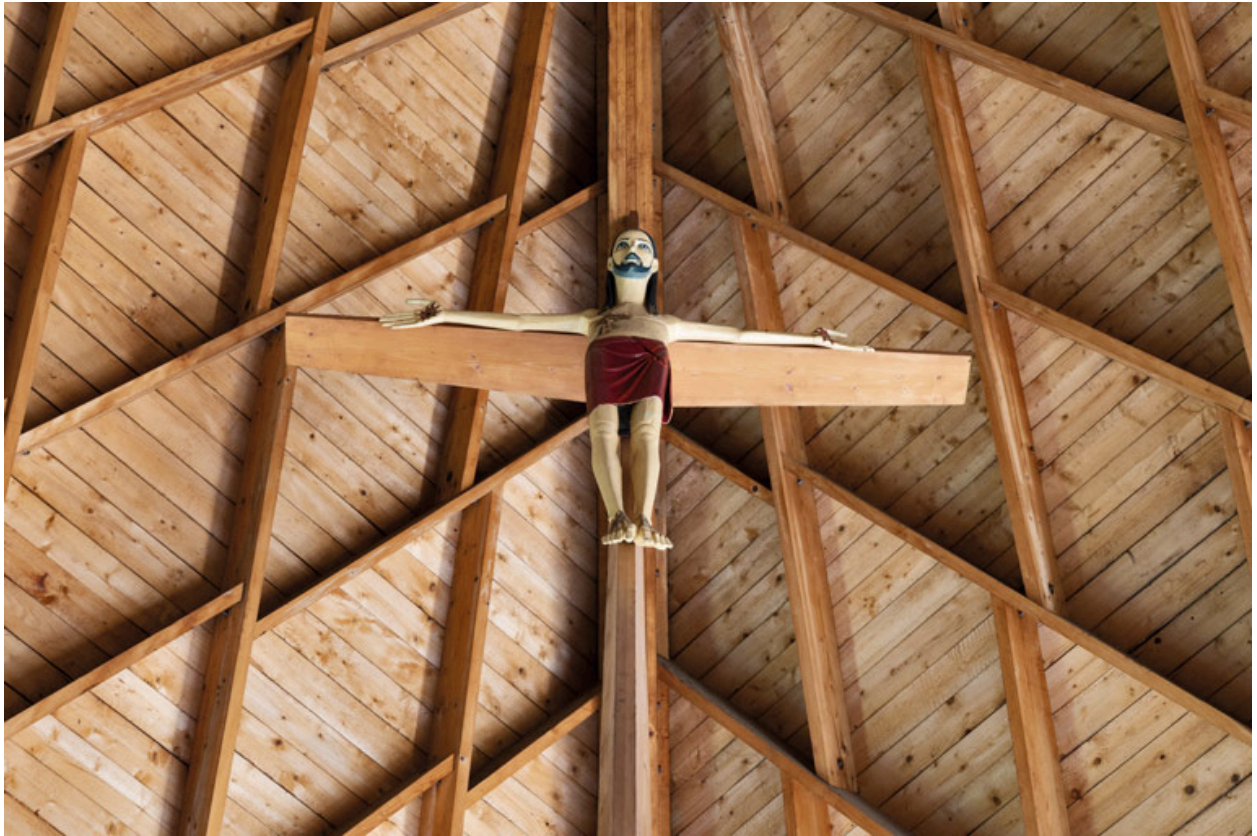
Poutre de gloire. Vue en contre-plongée.
