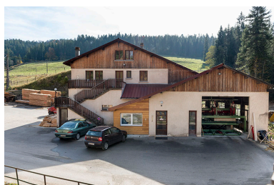
Bureaux et ateliers de conditionnement et de réparation. Phot. Sonia Dourlot IVR43_20172501789NUC4A
