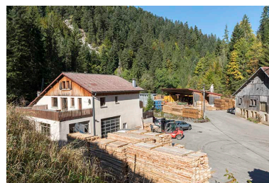
Vue d'ensemble des bureaux, des ateliers à l'ouest et de l'ancienne scierie. Phot. Sonia Dourlot IVR43_20172501790NUC4A
