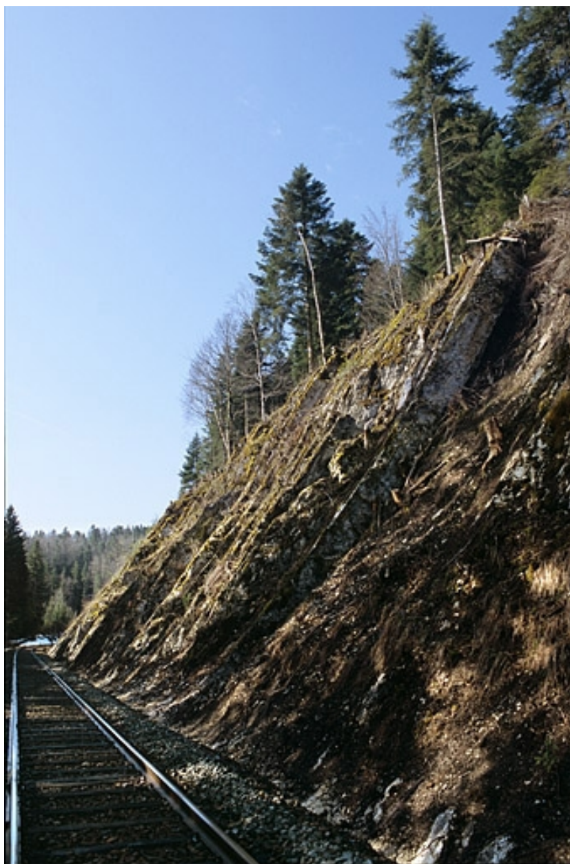
La voie sur la commune de La Chaux-du-Dombief : paroi rocheuse à proximité du tunnel du Morillon. Entre les PK 028.000 et 029.000.
