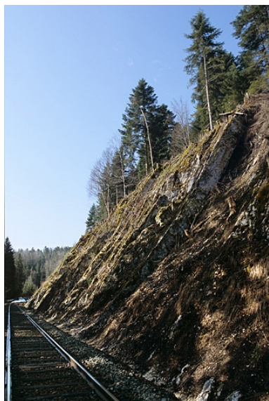
La voie sur la commune de La Chaux-du-Dombief : paroi rocheuse à proximité du tunnel du Morillon. Entre les PK 028.000 et 029.000. Phot. Yves Sancey IVR43_20053900222ZA
