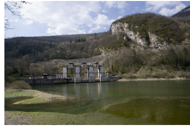
La voie et la vallée de la Bienne au barrage d'Etalles (Saint-Claude). Vers le PK 077.100. Phot. Yves Sancey IVR43_20073900177NUCA
