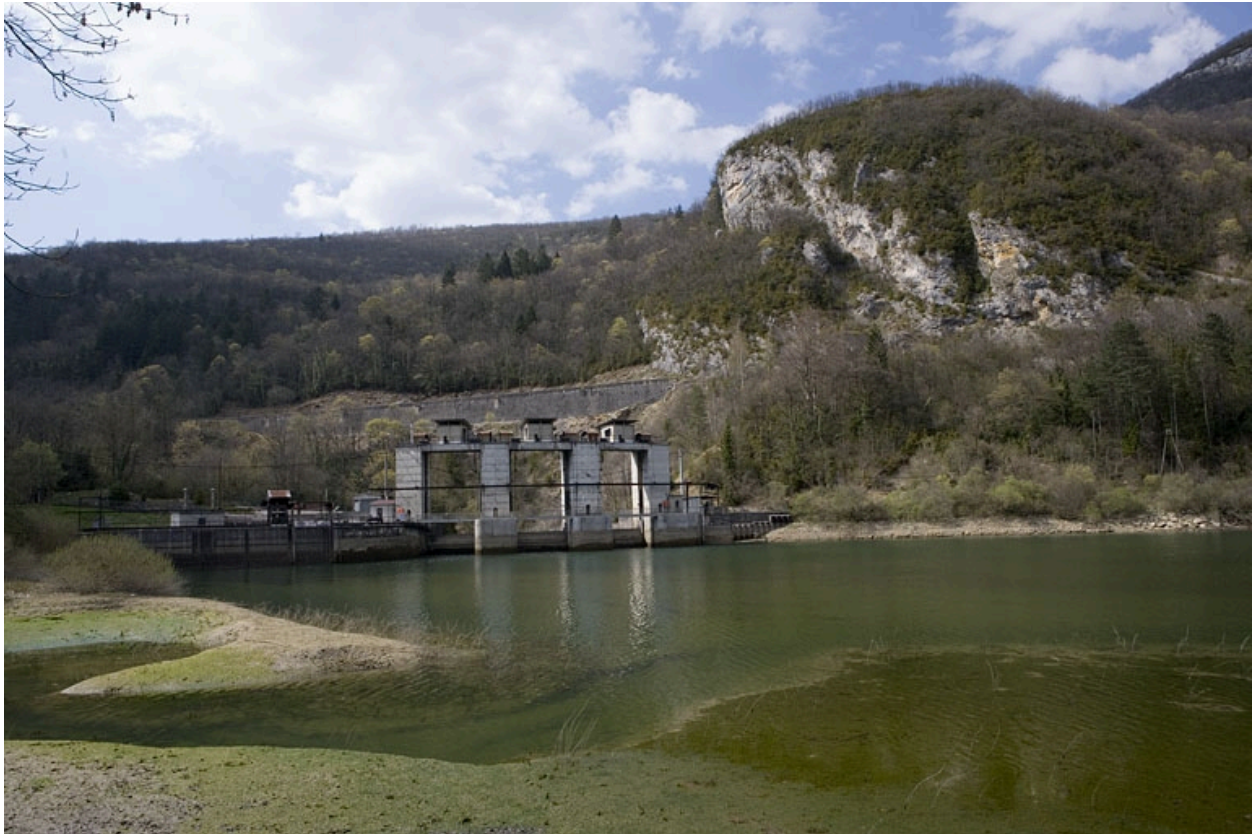
La voie et la vallée de la Bienne au barrage d'Étables (Saint-Claude). Vers le PK 077.100.
