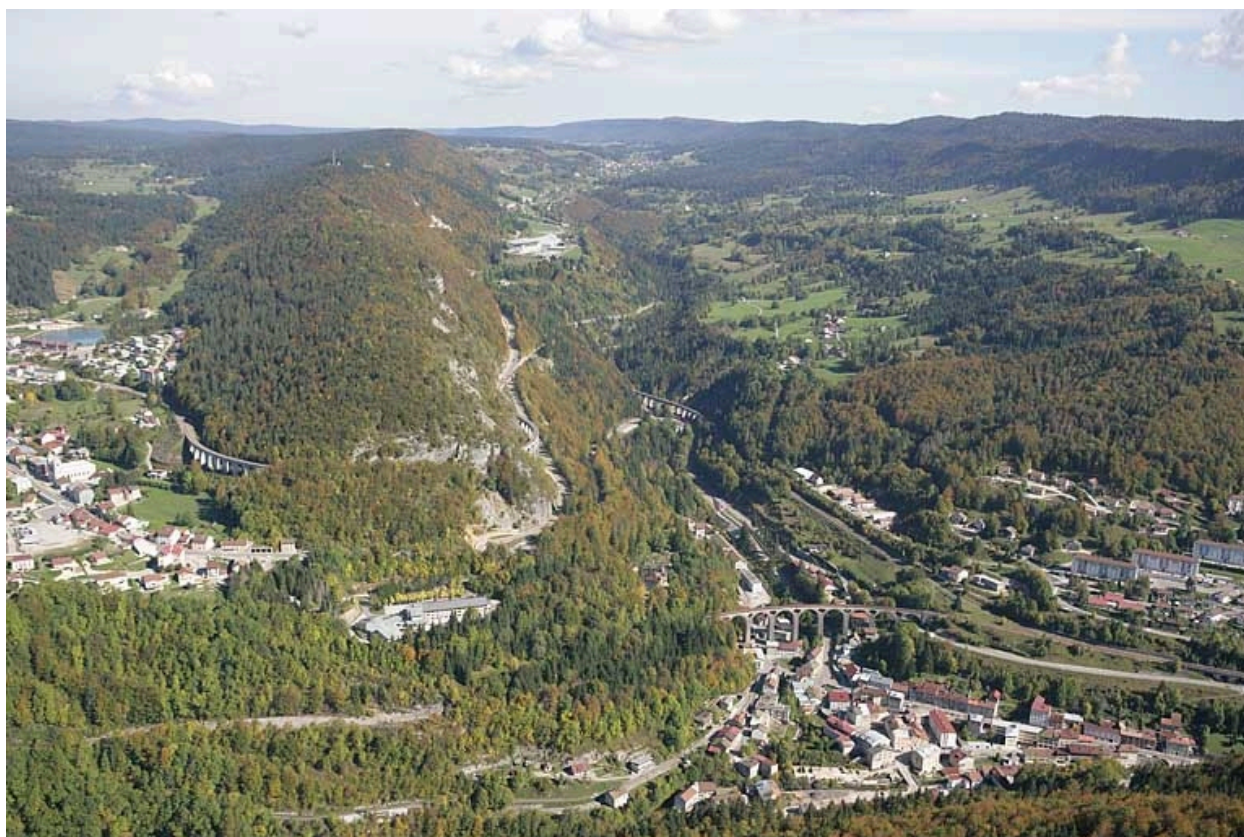
Vue aérienne des ouvrages de Morbier et Morez, depuis le sud-ouest. PK de 044.000 à 050.000.
