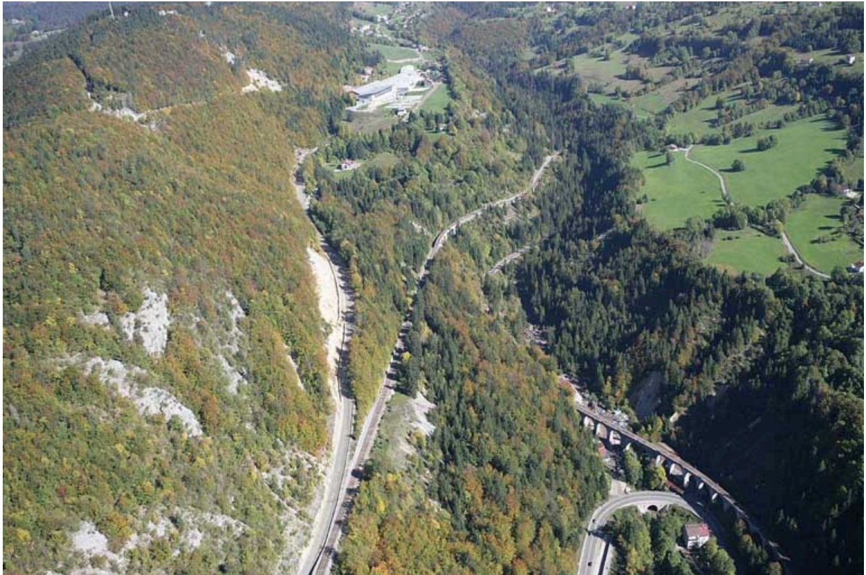
Vue aérienne des ouvrages situés entre les viaducs des Crottes et de la Source (Morbier, Bellefontaine, Morez), depuis le sud-ouest. PK de 045.200 à 048.000.
