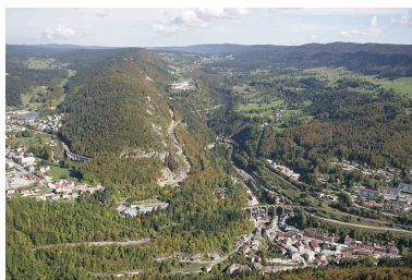
Vue aérienne des ouvrages de Morbier et Morez, depuis le sud-ouest. PK de 044.000 à 050.000. Phot. Jean-Pierre Bévalot IVR43_20053900997NUCA
