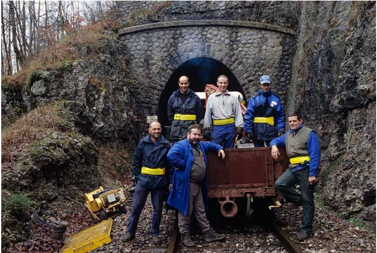
Equipe d'entretien de la voie, à l'extrémité du tunnel de Tancua côté Andelot-en-Montagne. PK 052.913.
