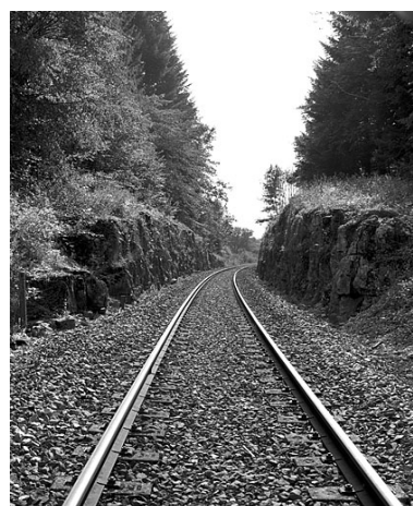
Vers-en-Montagne : tranchée proche de la maison de garde-barrière n° 1. Phot. Yves Sancey IVR43_20043900112X
