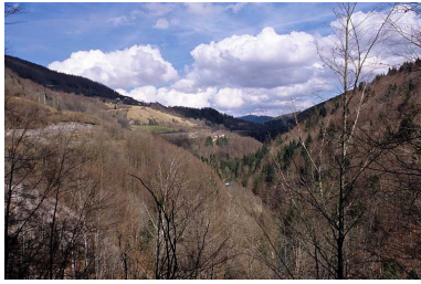
Voie ferrée dans la zone Tancua - Lézat : implantation dans la vallée de la Bienne. PK 052.000 à 058.000. Phot. Yves Sancey IVR43_20053900657ZA
