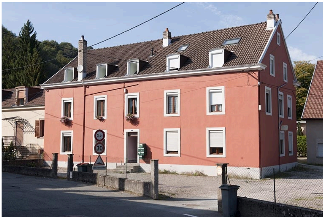
Logement ouvrier (2 rue de la République).
