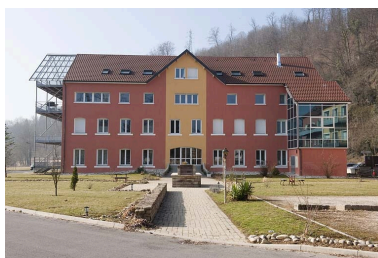
Façade est d'un atelier de fabrication (décolletage, construction des sous-ensembles, montage des porte échappements et contrôle). Phot. Jérôme Mongreville IVR43_20122500207NUC4A
