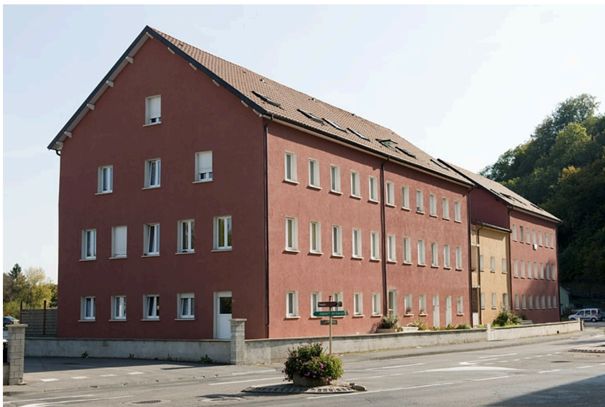
Ateliers de fabrication vus depuis le nord-ouest.
