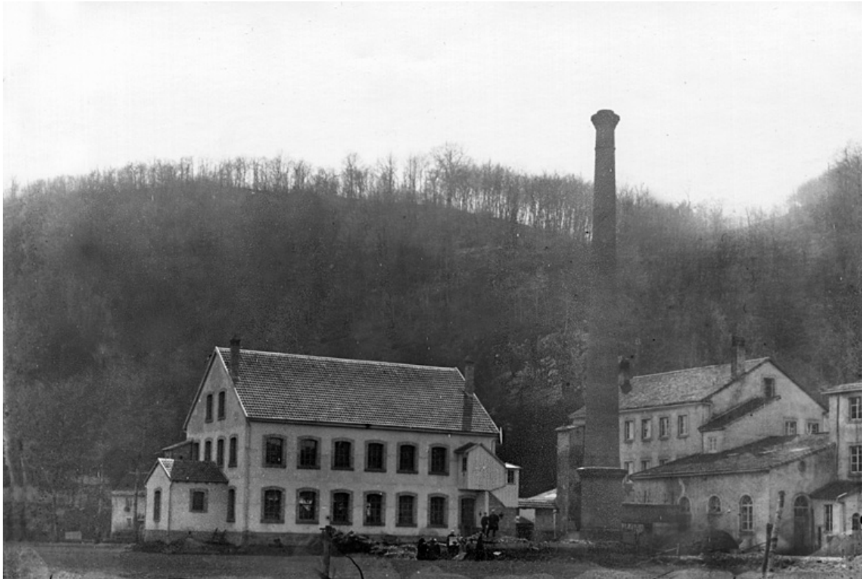
Vue d'ensemble depuis le nord. Photogr., s.n., s.d. [fin 19e ou début 20e siècle].
