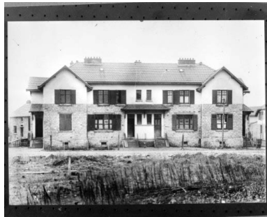
Façade antérieure. Phot. , Autr. Charnotet IVR43_19903900116X
