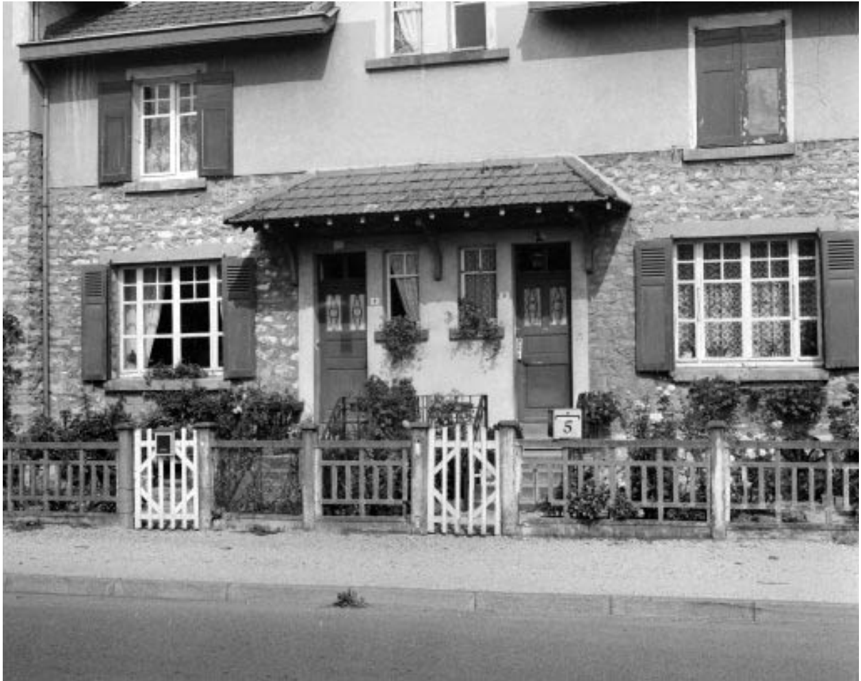
Façade antérieure, détail.
