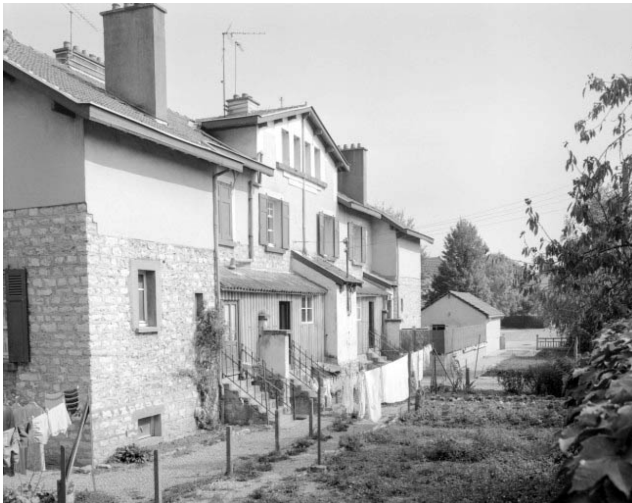
Façade postérieure d'un immeuble identique, 2, 4, 6, 8 place Victor Hugo.
