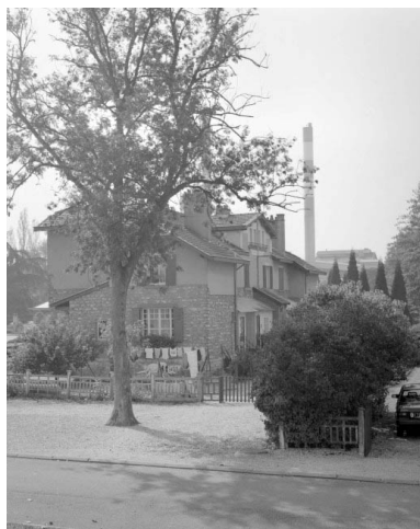
Façade postérieure et face droite. Phot. Yves Sancey IVR43_19893900494X
