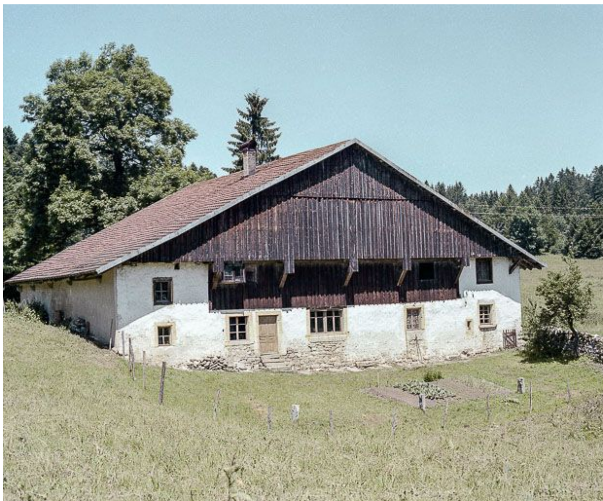
Façades antérieure et latérale droite.
