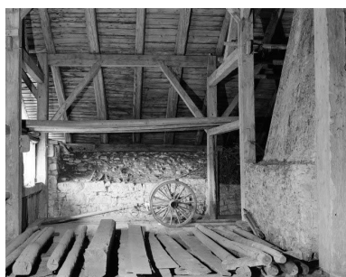
Grange et extrados de la voûte de cave. Phot. Dominique Dominguez IVR43_19792500272X
