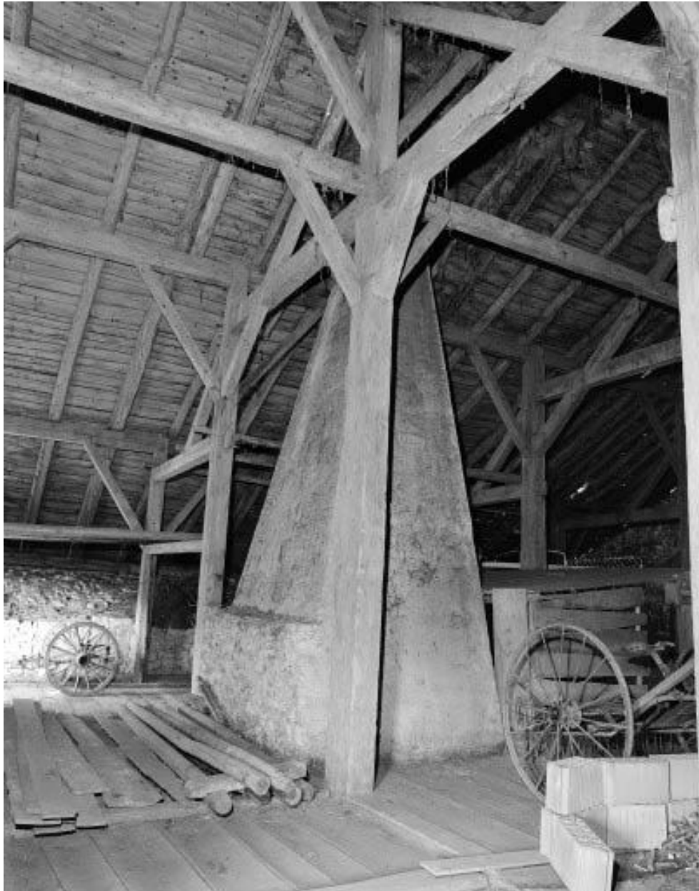
Charpente et conduit de cheminée.
