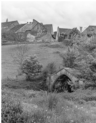
Vue de situation en 1981. Phot. Yves Sancey IVR43_19813900200X
