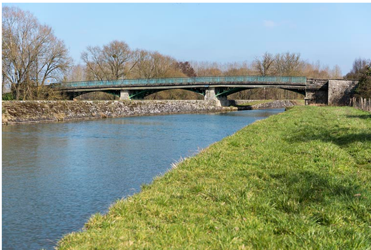
Vue depuis l'aval
