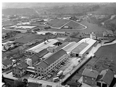
Vue aérienne depuis le nord. Phot. Jérôme Mongreville IVR43_19973900956X
