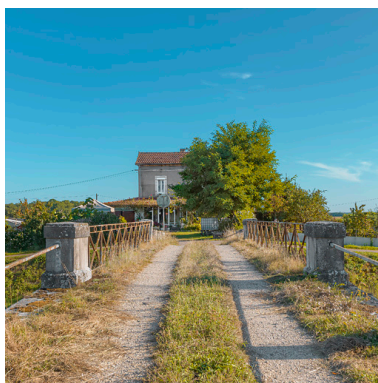
Vue d'ensemble du pont sur l'écluse depuis la rive droite. En face, la maison éclésièrè. Phot. Thierry Kuntz IVR26_20197100498NUC2A
