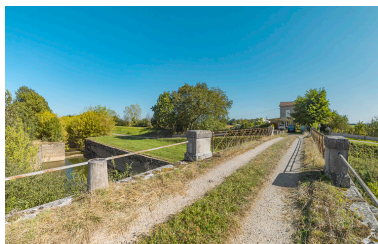
Vue d'ensemble du pont sur l'écluse depuis la rive droite. En face, la maison éclésièrè. Phot. Thierry Kuntz IVR26_20197100495NUC4A
