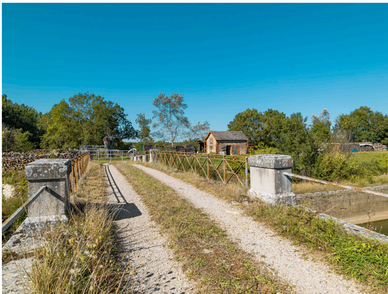
Vue d'ensemble du pont sur l'écluse.
