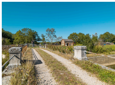
Vue d'ensemble du pont sur l'écluse. Phot. Thierry Kuntz IVR26_20197100501NUC4A
