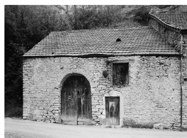
Cuveries (parcelle 71, section B1 du cadastre de 1953). Phot. Jean-Luc Duthu IVR26_19802100416V
