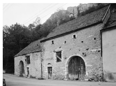
Vue d'ensemble des cuveries (parcelle 71, section B1 du cadastre de 1953). Phot. Jean-Luc Duthu IVR26_19802100417V
