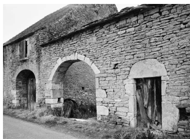
Dépendances et portail. Phot. Jean-Luc Duthu IVR26_19802100388V
