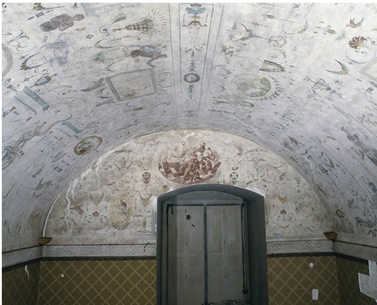
Chambre du Zodiaque, mur ouest, vue générale
