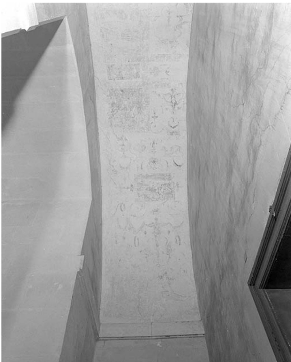
Chambre du Zodiaque, couloir, voûte, partie sud
