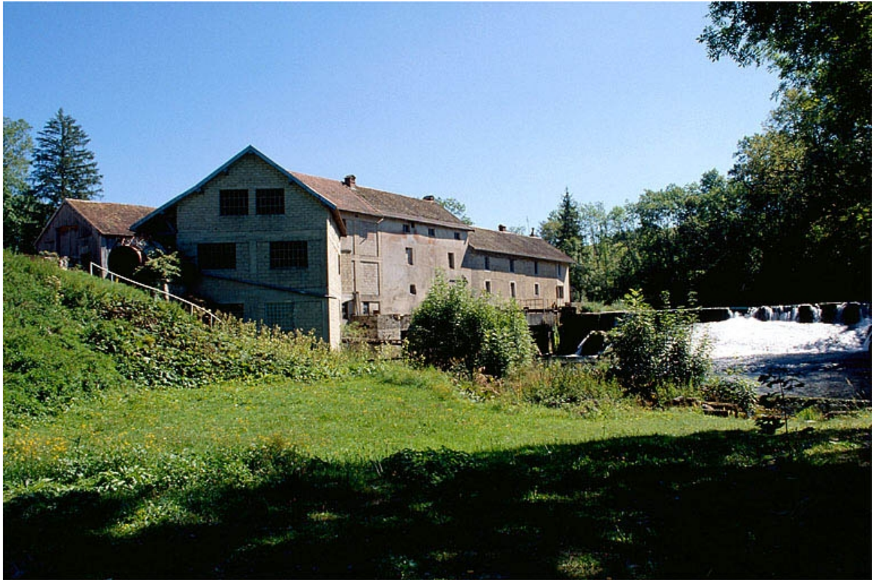
Façades postérieures vues de trois quarts gauche.
