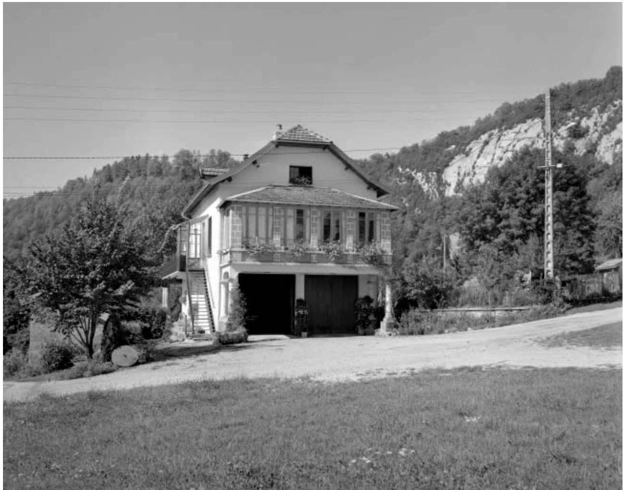
Logement patronal depuis l'est.
