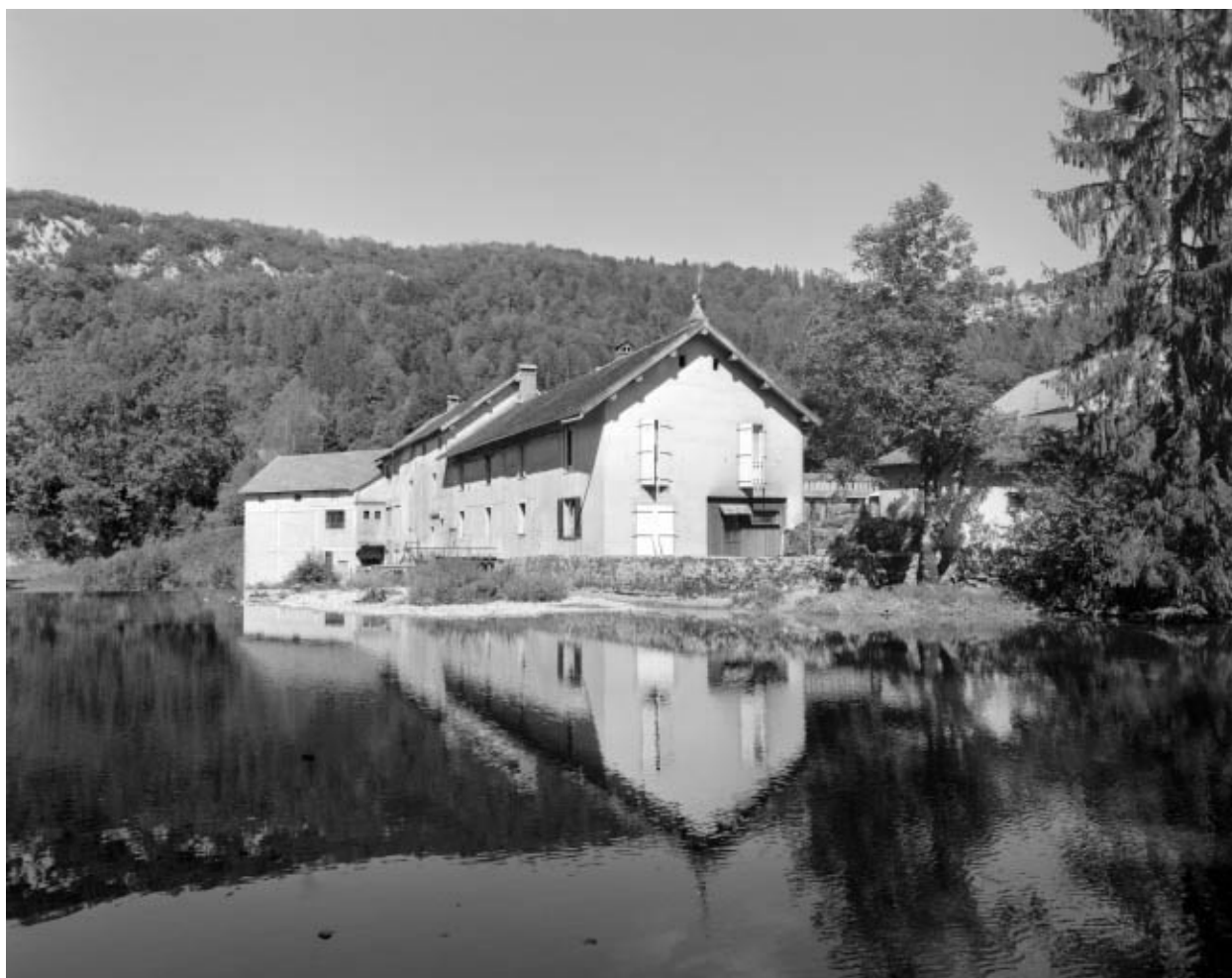
Vue d'ensemble depuis l'amont.
