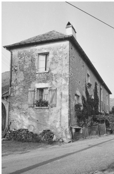
Partie habitation. Phot. Bernard Lardière IVR43_19797000313Z
