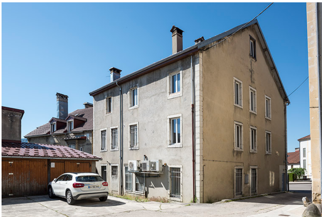
Façades postérieure et latérale gauche.
