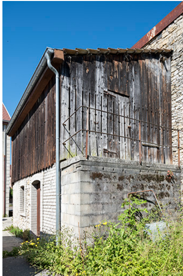
Dépendance. Phot. Sonia Dourlot IVR43_20182501028NUC4A
