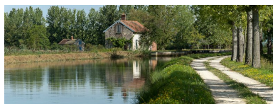
Vue du site d'écluse depuis l'amont. Phot. Pierre-Marie Barbe-Richaud IVR26_20112103896NUC4AQ
