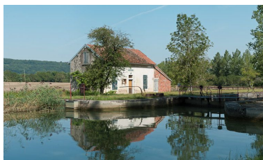
Vue du site d'écluse depuis l'amont. Phot. Pierre-Marie Barbe-Richaud IVR26_20112103899NUC4AQ
