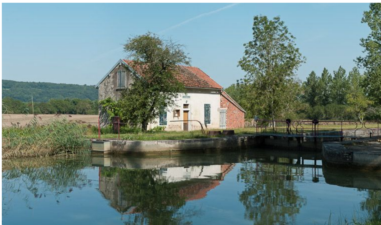
Vue du site d'écluse depuis l'amont.
