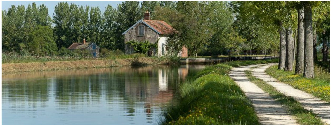
Vue du site d'écluse depuis l'amont.
