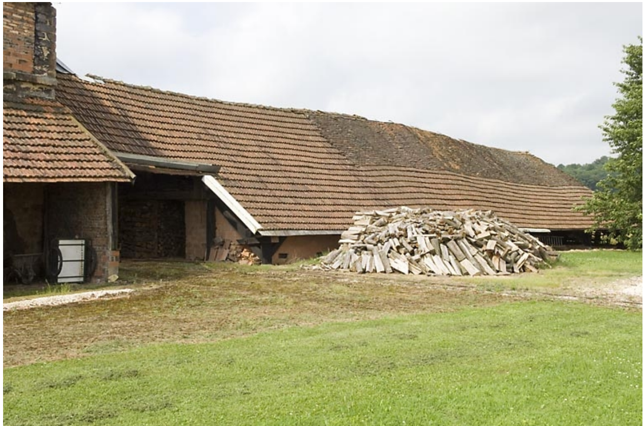
Le séchoir vu depuis le nord-est.
