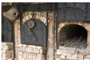
Gueules de charge du four, avec système d'ouverture à contrepoids. Phot. Jérôme Mongreville IVR43_20087000762NUC2A
