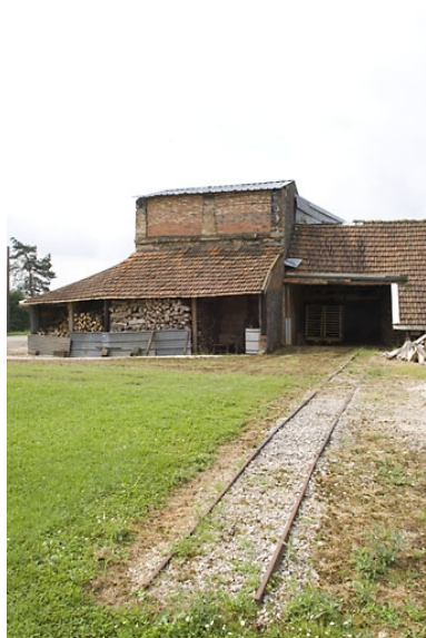
Le four vu depuis le nord. Phot. Jérôme Mongreville IVR43_20087000765NUC2A
