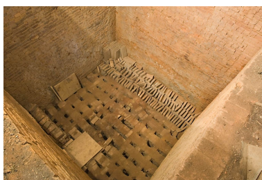
La sole vue depuis la partie supérieure du four. Phot. Jérôme Mongreville IVR43_20087000797NUC2A
