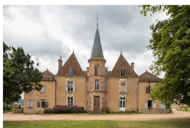
Façade postérieure de la demeure. Phot. Pierre-Marie Barbe-Richaud IVR26_20187100218NUC4A
