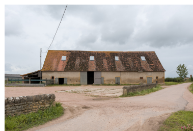
Façade antérieure du bâtiment agricole. Phot. Pierre-Marie Barbe-Richaud IVR26_20187100211NUC4A
