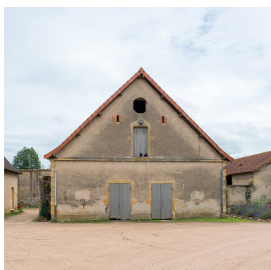
Pignon d'une dépendance agricole. Phot. Pierre-Marie Barbe-Richaud IVR26_20187100225NUC4A
