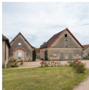
Dépendances agricoles. Phot. Pierre-Marie Barbe-Richaud IVR26_20187100224NUC4A
