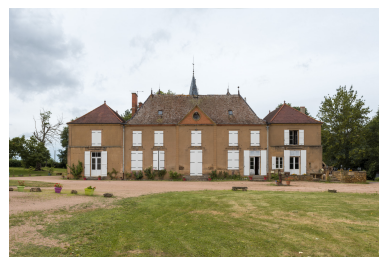
Façade antérieure de la demeure. Phot. Pierre-Marie Barbe-Richaud IVR26_20187100217NUC4A
