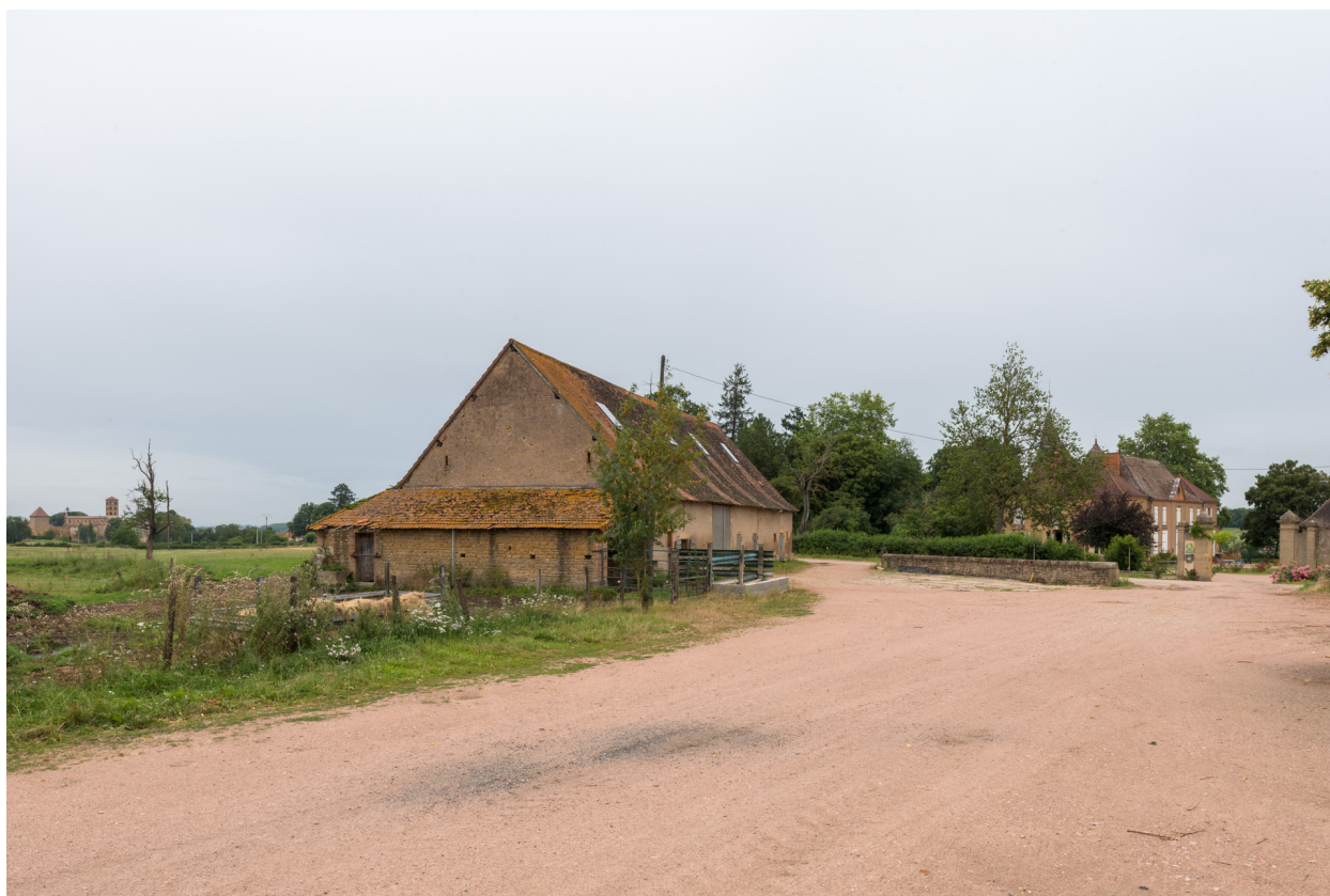
Le bâtiment agricole et le château depuis le sud-ouest.
