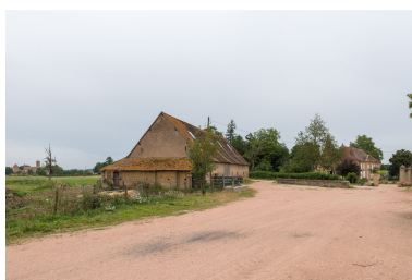
Le bâtiment agricole et le château depuis le sud-ouest. Phot. Pierre-Marie Barbe-Richaud IVR26_20187100210NUC4A
