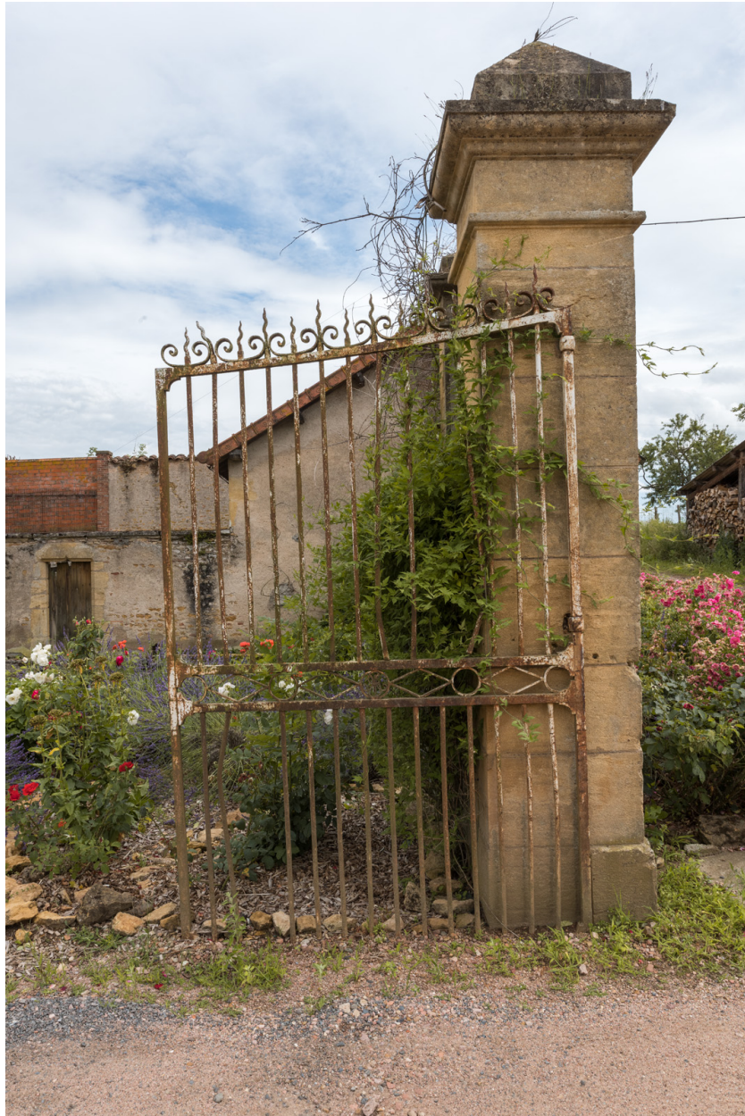
Détail du portail d'entrée de la demeure.
