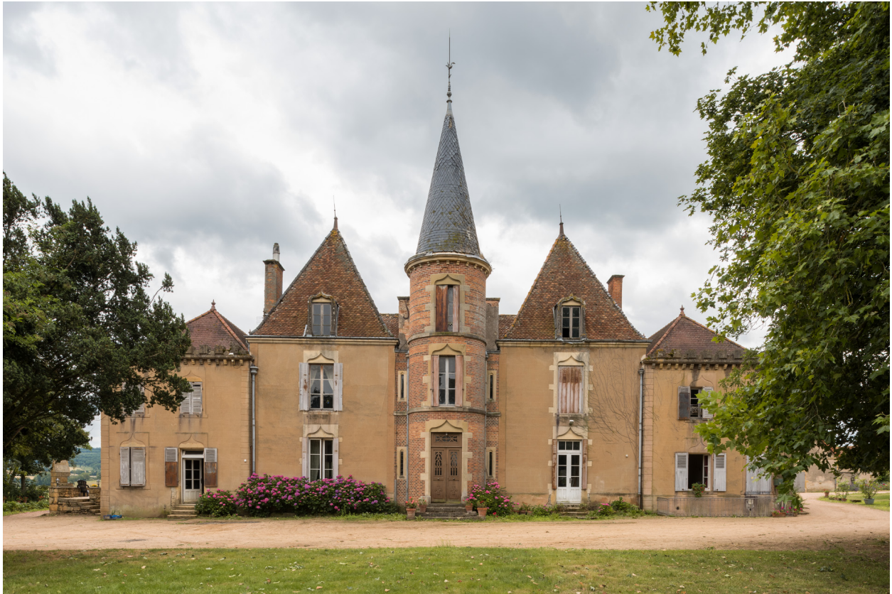
Façade postérieure de la demeure.
