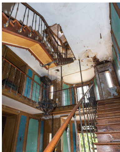
Escalier d'accès à la tourelle (extension nord fin 19e siècle). Phot. Pierre-Marie Barbe-Richaud IVR26_20187100221NUC4A
