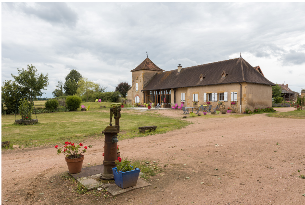
Remise et pigeonnier vus depuis le nord-est.
