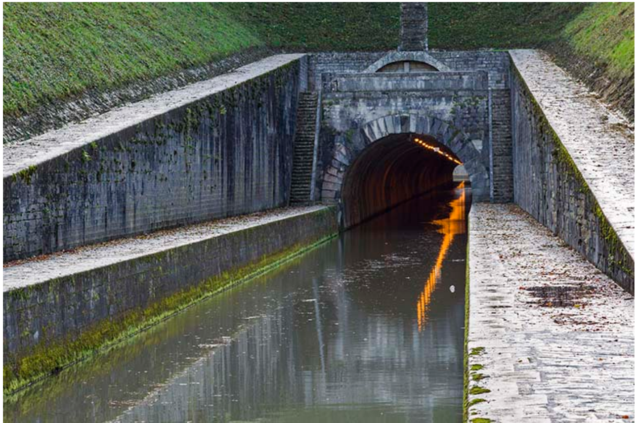
Le tunnel de Saint-Albin.
