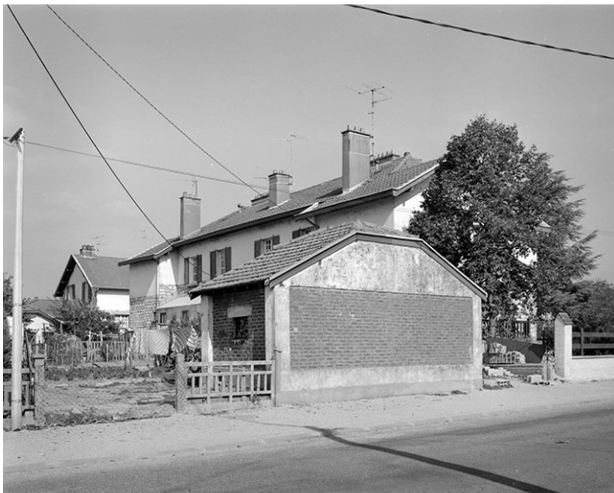
Façade postérieure et face latérale gauche.
