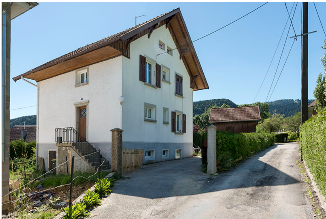
Maison : façades antérieure et latérale gauche.
