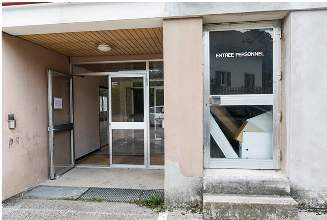
Usine : entrée sur la façade antérieure.
