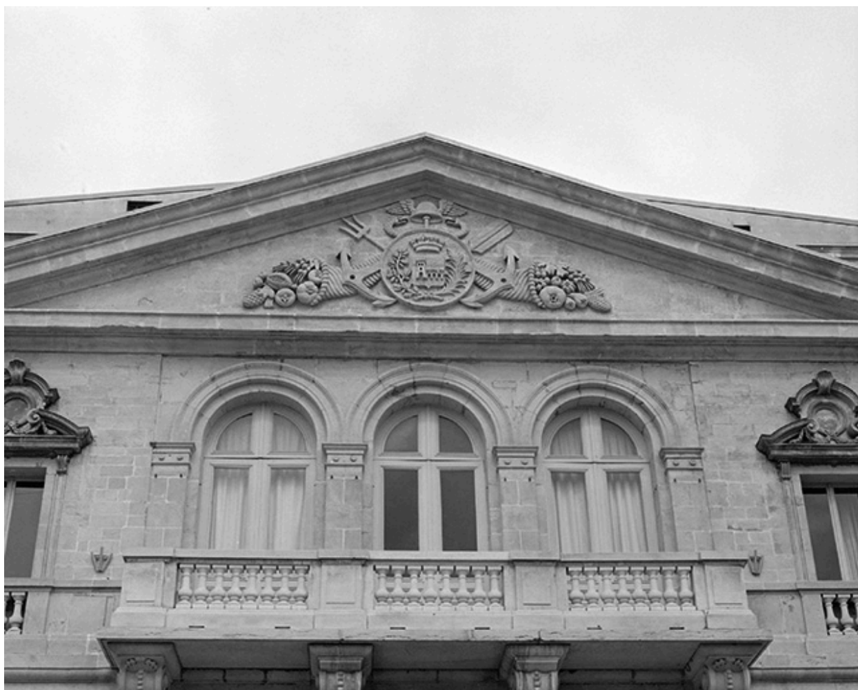
Façade antérieure. Corps central, fenêtre et fronton.
