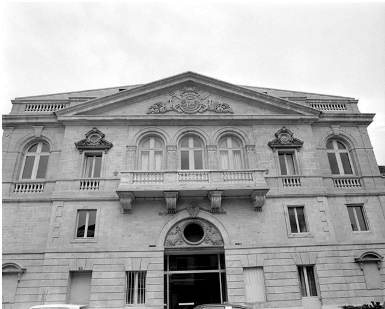
Façade antérieure. Corps central, vue d'ensemble.
