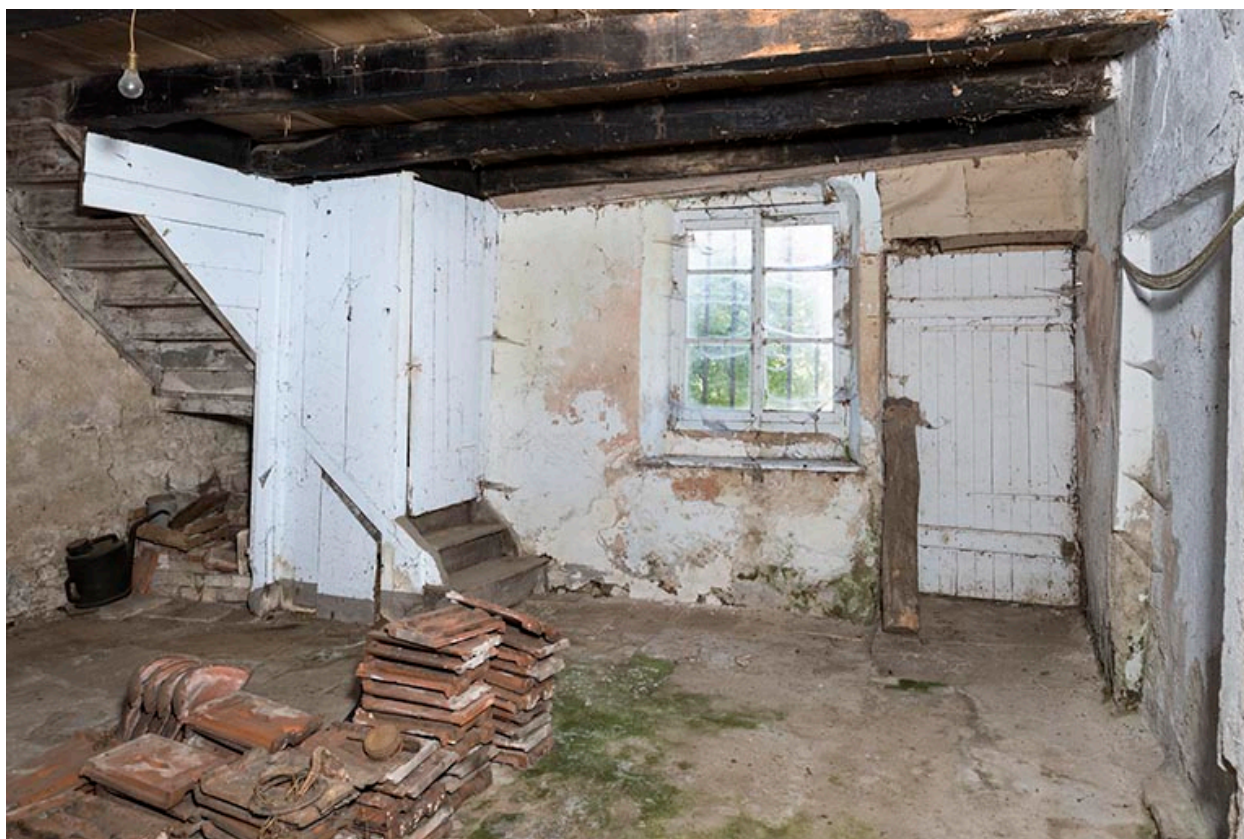
Intérieur : la cuisine en direction de l'entrée.
