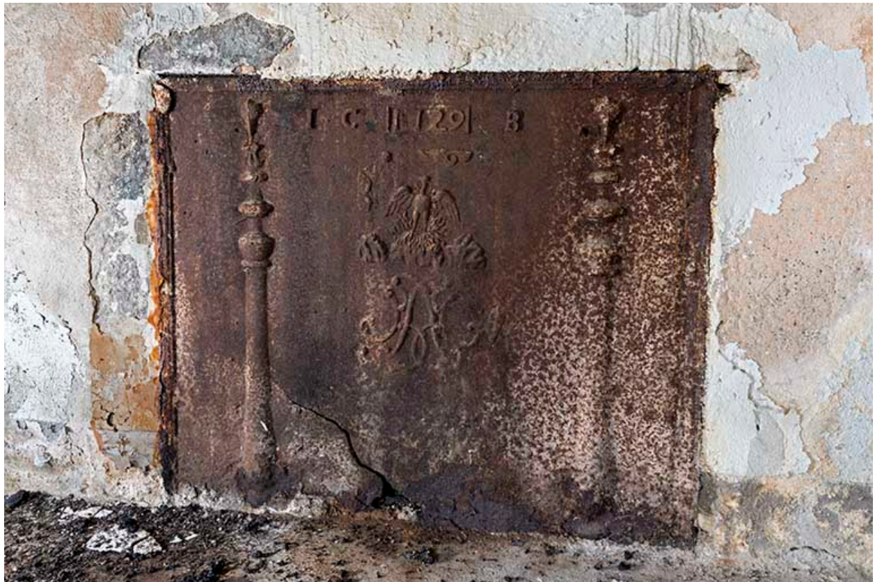
intérieur : la plaque de cheminée.
