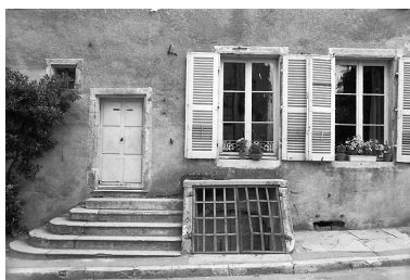
Détail du rez-de-chaussée. Phot. Bernard Lardière IVR43_19817000746Z
