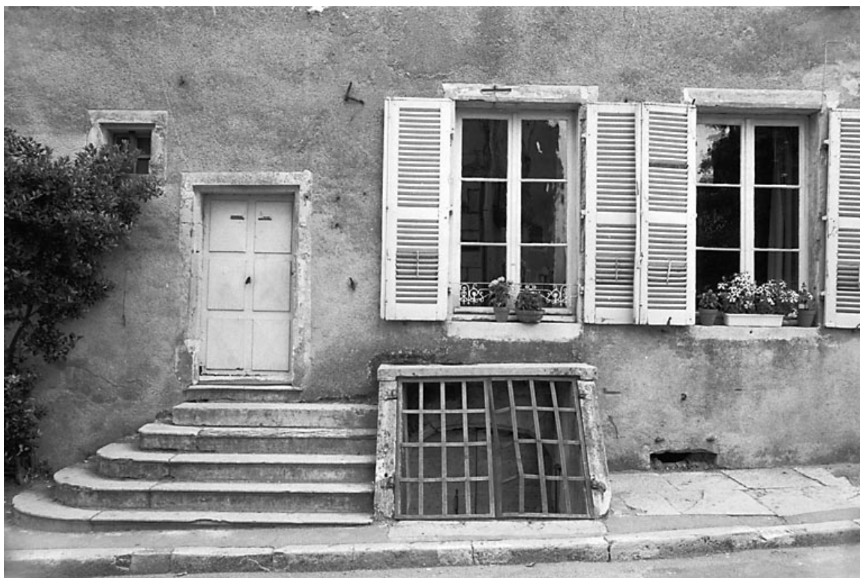
Détail du rez-de-chaussée.
