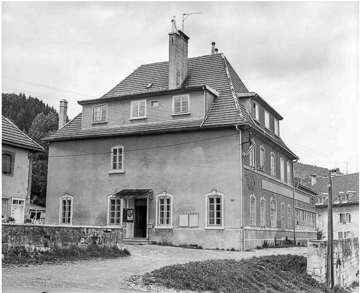
Vue d'ensemble depuis l'ouest, en 1976.
