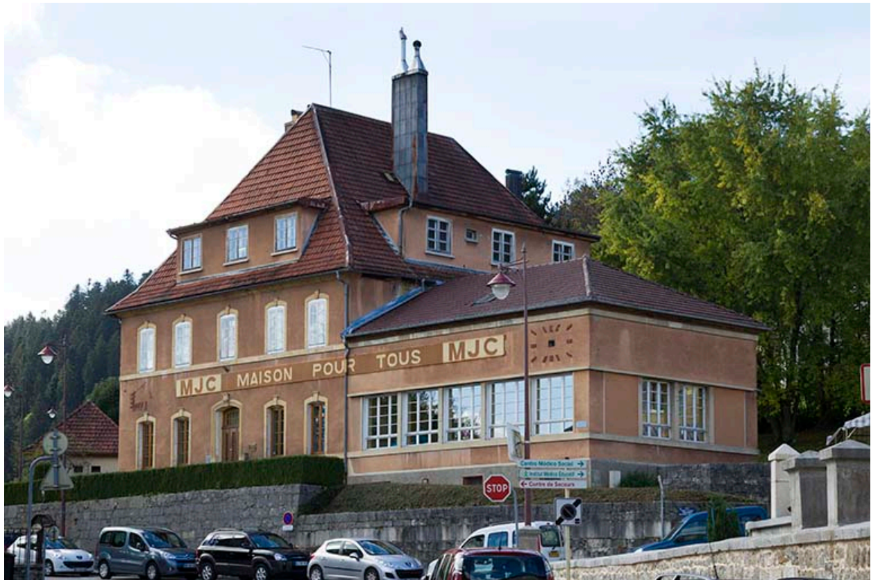
Façades antérieure et latérale droite.
