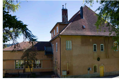
Façade postérieure. Phot. Yves Sancey
