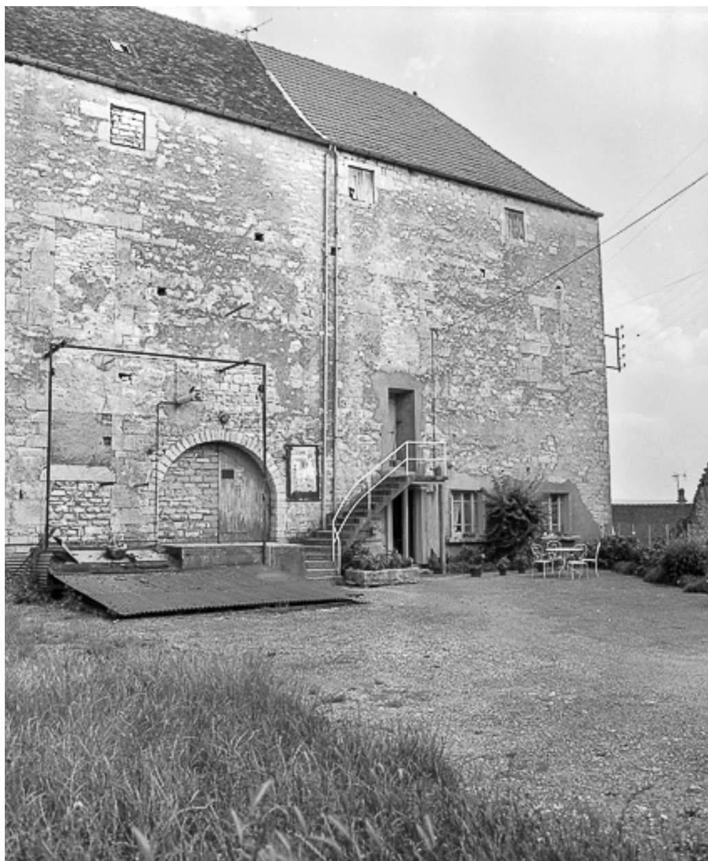
Façade antérieure : partie droite.
