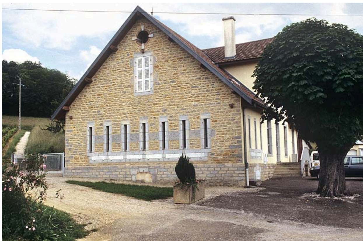
Façade latérale gauche (chambre à lait).
