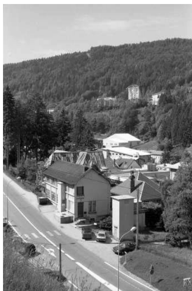
Vue d'ensemble plongeante. Phot. Laurent Poupard IVR43_19913901466Z
