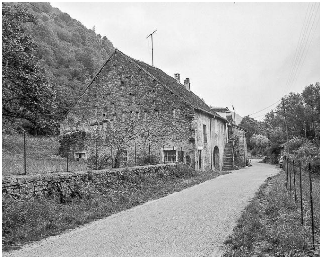
Maison de vigneron située à Vaux-sous-Bornay.
