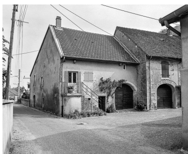
Maison du maréchal-ferrant située rue de l'Huilerie. Phot. Yves Sancey IVR43_19843900252X
