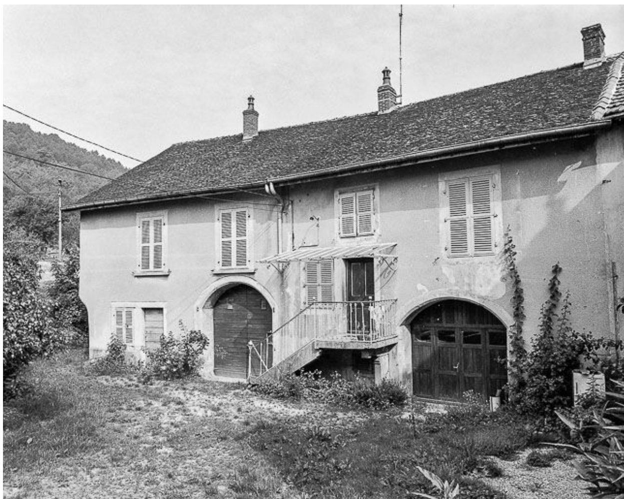
Maison de vigneron située à Vaux-sous-Bornay.
