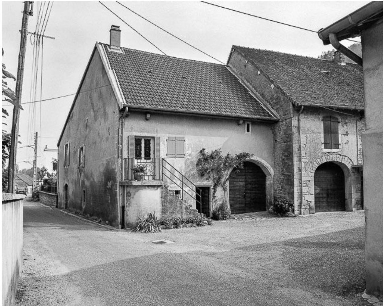
Maison du maréchal-ferrant située rue de l'Huilerie.
