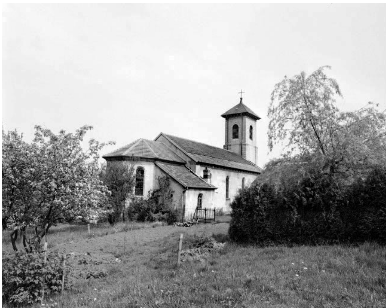
Façade latérale droite et chevet.
