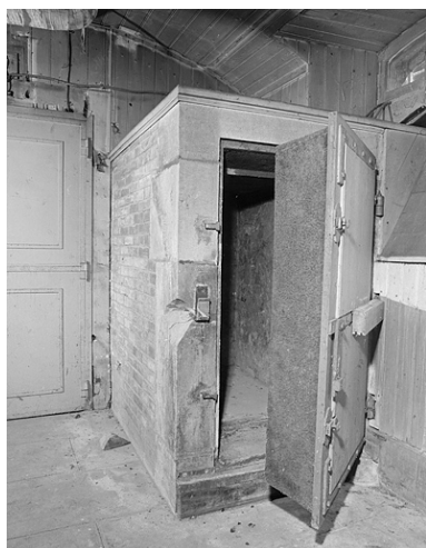
Vue d'ensemble. Phot. Jérôme Mongreville IVR43_20022501145X
