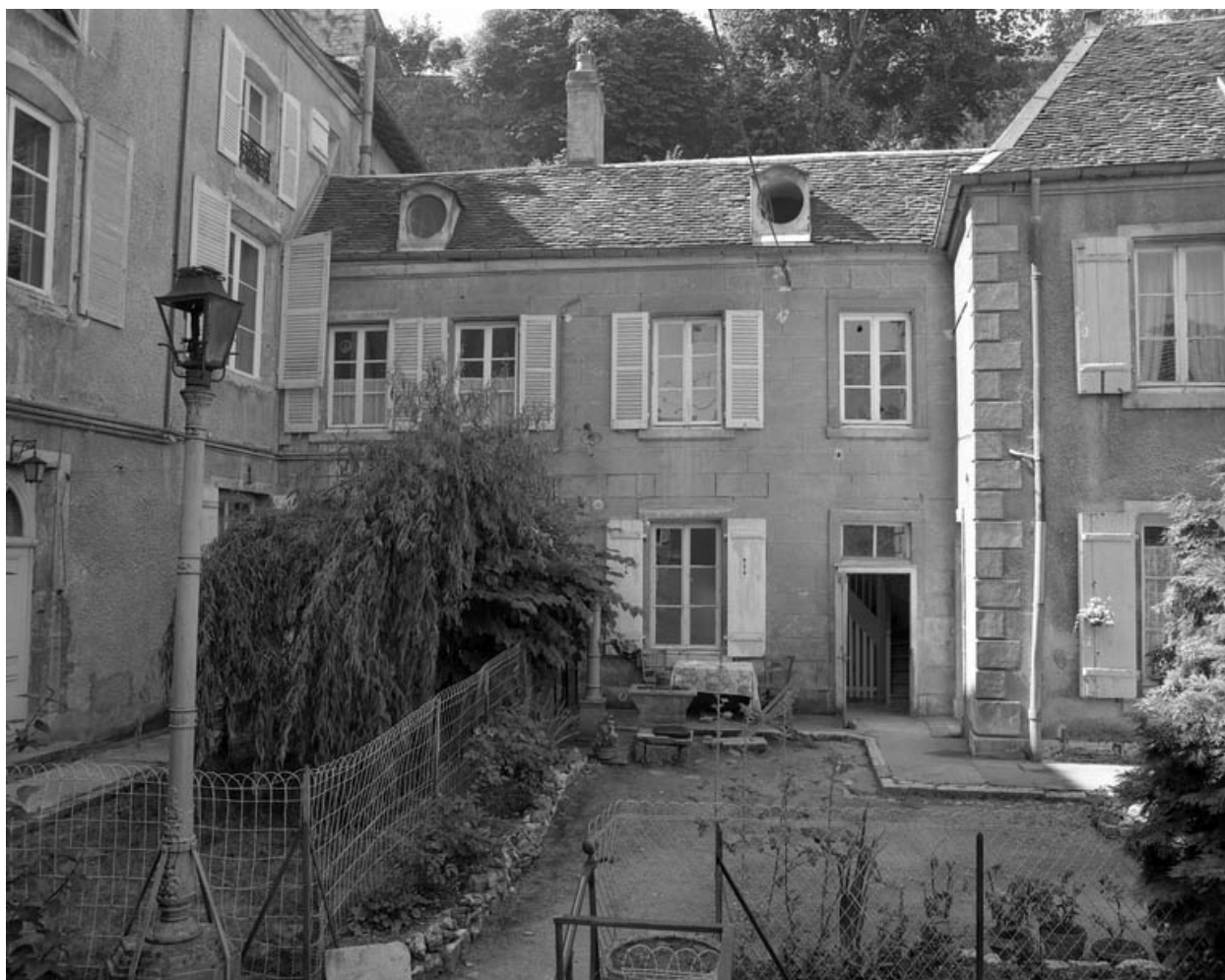
Logement annexe gauche : façade antérieure de face.
