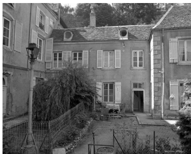
Logement annexe gauche : façade antérieure de face.
