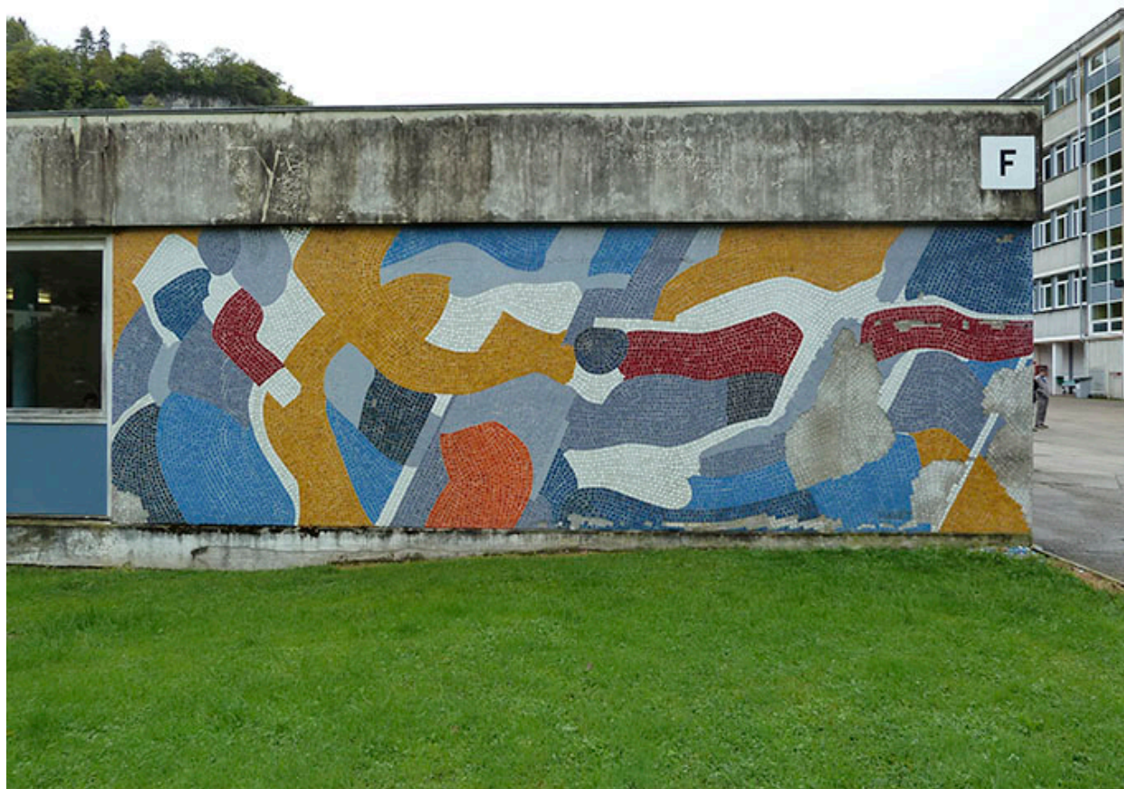
Vue générale, avant masquage par façade.
