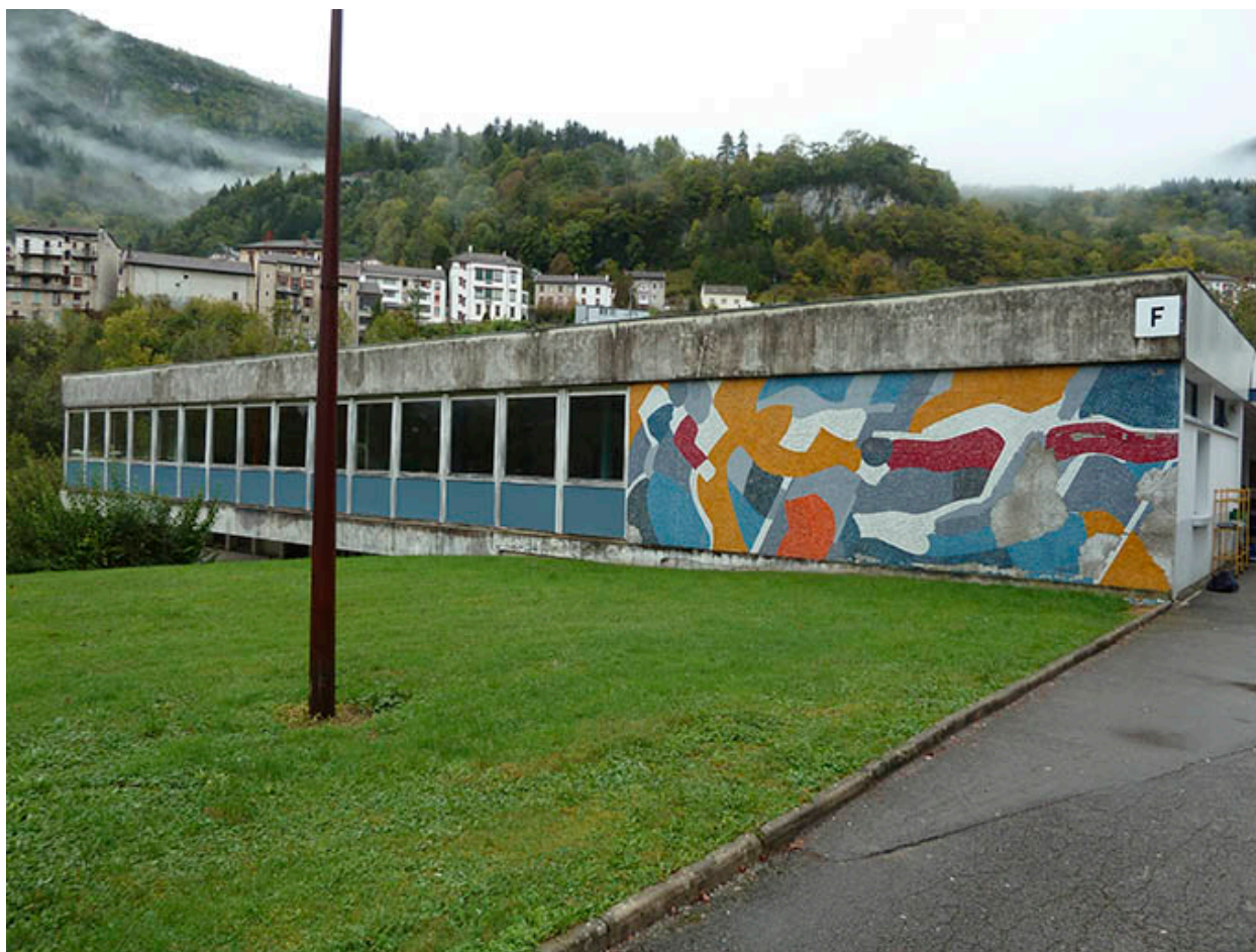
Vue générale, avant restauration du bâtiment.
