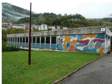
Vue générale, avant restauration du bâtiment. Phot. Philippe Mairot IVR43_20143900793NUC4A
