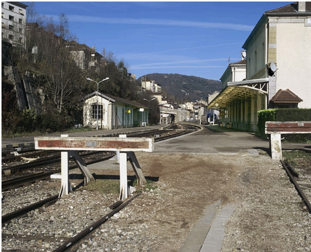
Vue d'ensemble des butoirs.
