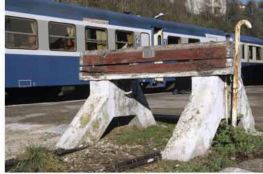
Butoir de la voie 5. Phot. Yves Sancey IVR43_20043900427ZA
