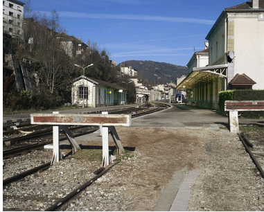
Vue d'ensemble des butoirs. Phot. Yves Sancey IVR43_20043900405XA
