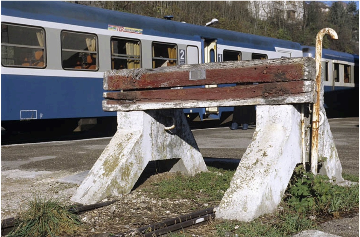
Butoir de la voie 5.
