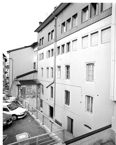
Elévation postérieure, de trois quarts droite. Phot. Yves Sancey IVR43_20033900593X
