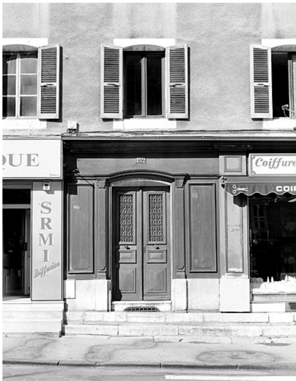
Elévation antérieure : porte principale et fenêtre du premier étage. Ces baies ont un linteau délardé en arc segmentaire.
