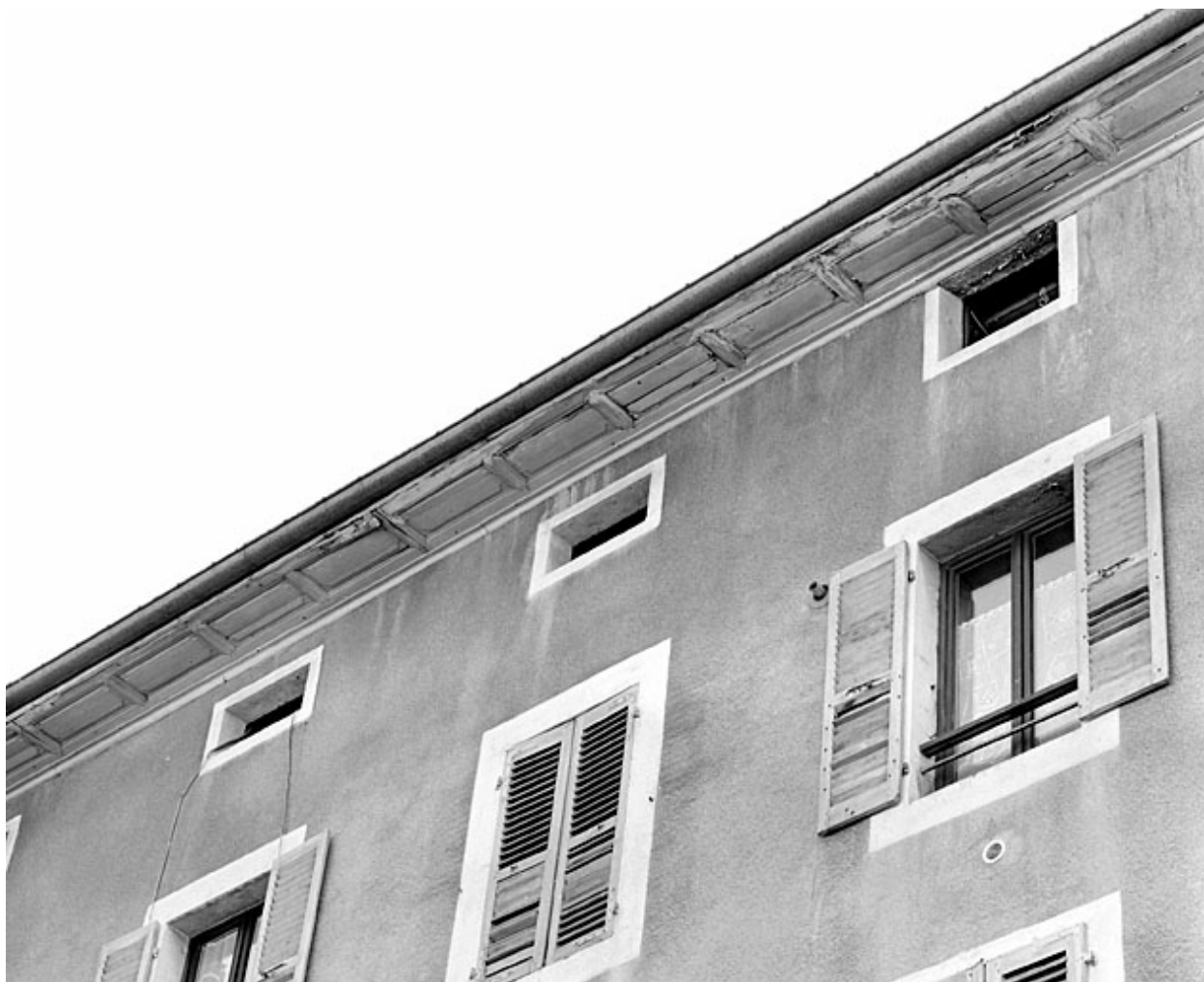
Elévation antérieure : corniche et fenêtres du comble à surcroît.
