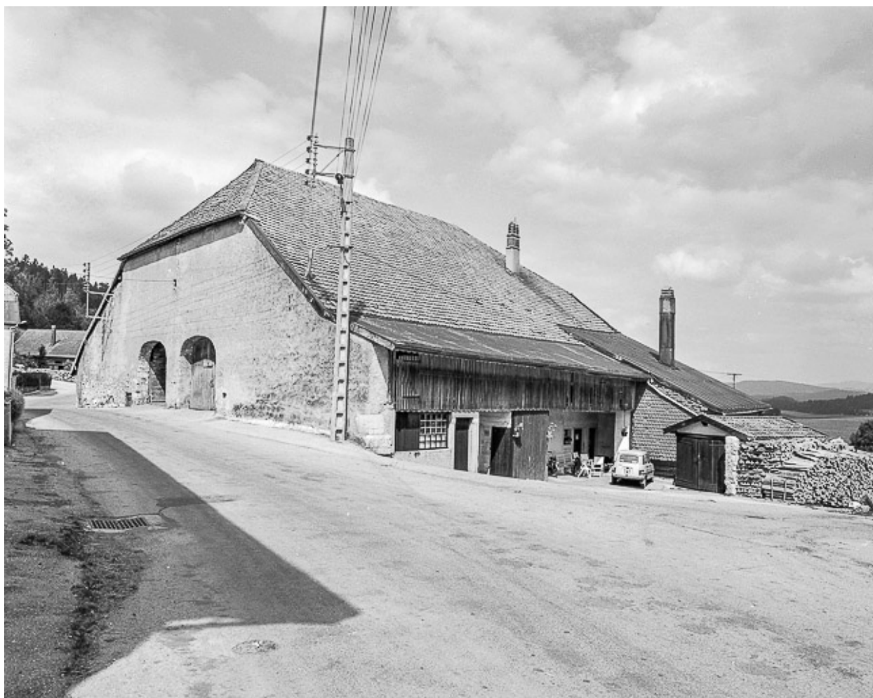
Pignon sur rue et goutterot.
