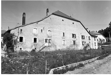
Façade antérieure. Phot. Dominique Dominguez IVR43_19792500996X
