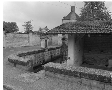
Détail de la partie source Phot. Jean-Luc Duthu IVR26_20018900159X
