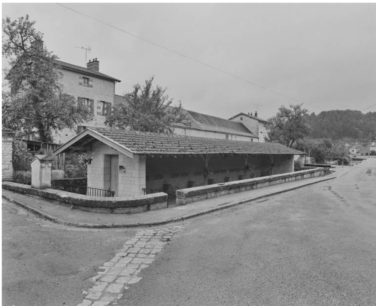
Vue d'ensemble coté source
