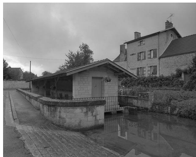
Vue d'ensemble Phot. Jean-Luc Duthu IVR26_20018900158X
