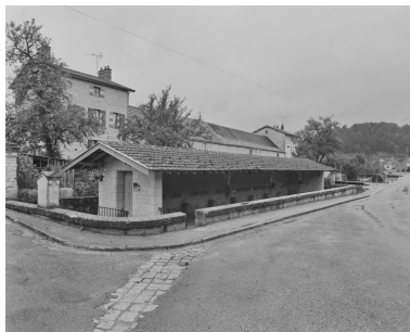
Vue d'ensemble coté source Phot. Jean-Luc Duthu IVR26_20018900157X
